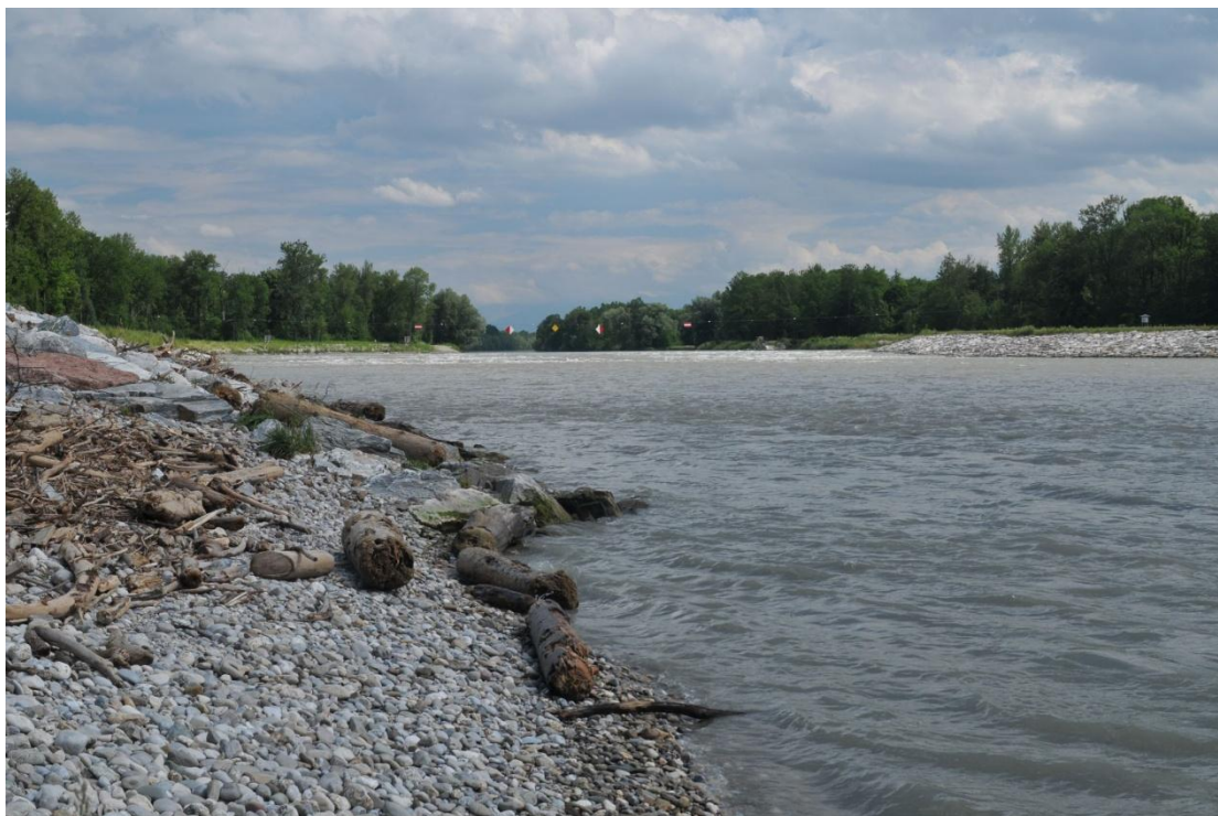
Abbildung 3-6: Sohlstabilisierung in der Salzach (Rampe) bei Flkm 51,9; unterhalb der Rampe zeigen die Maßnahmen schon ihre Wirkung: Dynamische Entwicklung der sogenannten "Weichen Ufer" (im Vordergrund links).
