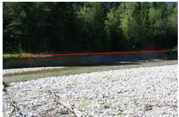
F68: linksufriger Uferanbruch – Beschädigung des Wanderweges; Maßnahmenvorschlag 3
