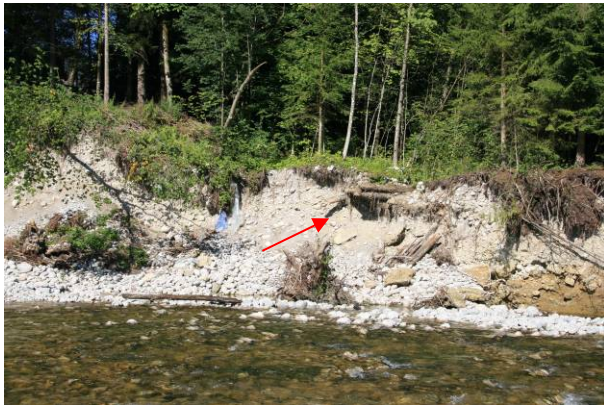
F35: Prallufer; Fragmente einer Holzkastenverbauung
