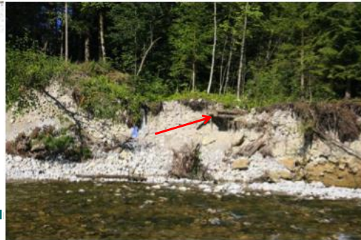
Prallufer; Fragmente einer Holzkastenverbauung
