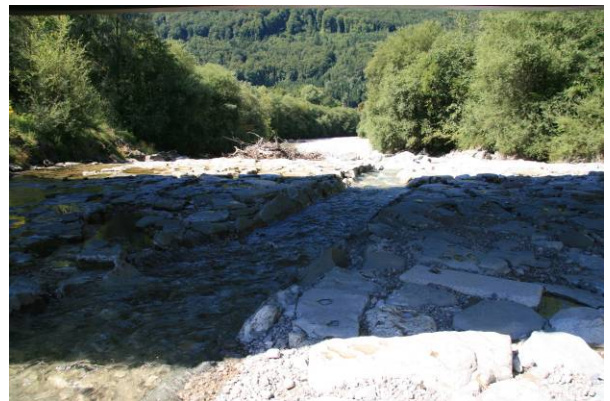
F87: Sohle unterhalb der Eisenbahnbrücke; Sohle: Grobsteinschichtung teilweise in Beton verlegt inkl. Niederwasserrinne
