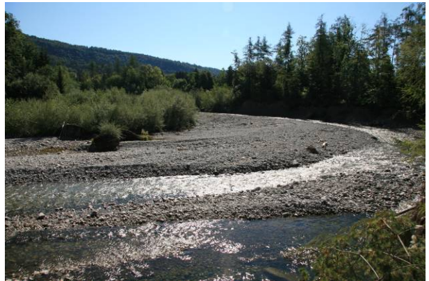
F38: Blickrichtung flussauf, Maßnahmenvorschlag M1 - Buhnenstrecke
