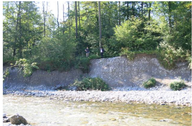
F33: linksufriger Steilufbereich mit aktuellen Erosionen, Höhe 5 bis 7 m – Maßnahmenvorschlag M1
