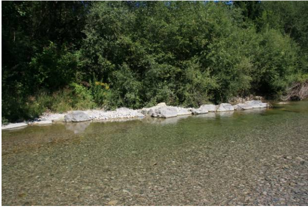
F71: rechtsufriger Steinwurf vor der Autobahnbrücke
