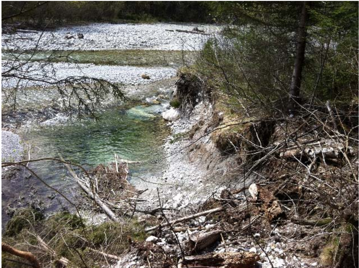
Abbildung 37: Erosionsufer, das mit Raubhaumen gesichert werden soll (Standort, Blickrichtung)
