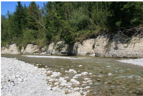
F63: ca. 5 m hohes rechtsufriges Steilufer
