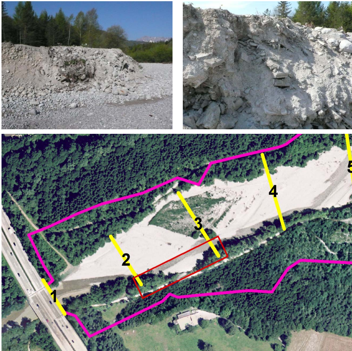
Abbildung 2: Zementabfälle in einer angeschütteten Böschung (rot eingerahmter Bereich)
