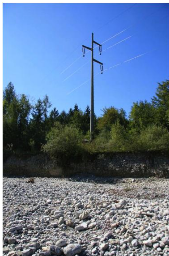
Strommast, nur wenige Meter vom Uferanbruch entfernt
