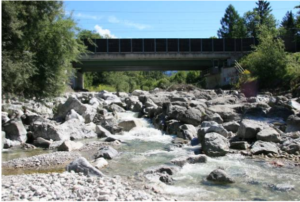
F95: Sohle flussab der Eisenbahnüberführung. Blickrichtung flussauf; rund 2,5 m Höhenunterschied auf 20 bis 30 m
