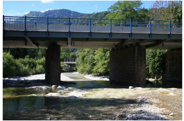
F78: Brücke Bundesstraße B159; Pfeiler gem. alter Flussachse (vor Autobahnbau) ausgerichtet; Sohle: GSS in Beton verlegt
