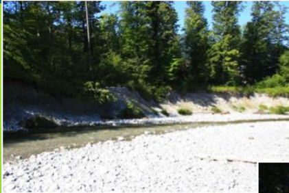
linksufriger Steiluferbereich – lokale Sicherung durch Buhnen
