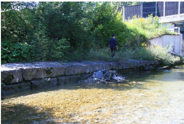
F86: Bereich Eisenbahnbrücke; linksufriges Zementmörtelmauerwerk; darüber Hochwasserschutzdamm
