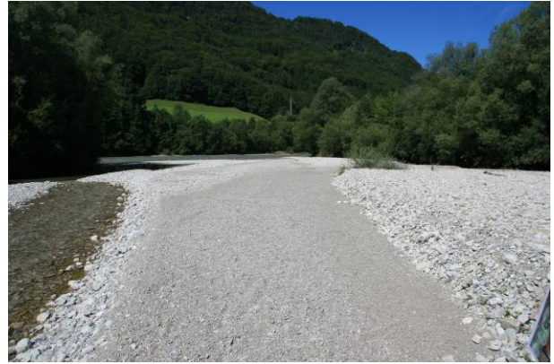
F99: Einmündungsstrecke in die Salzach; hohe Ablagerungstendenz; Ufer linksufrig mit überdeckter GSS gesichert
