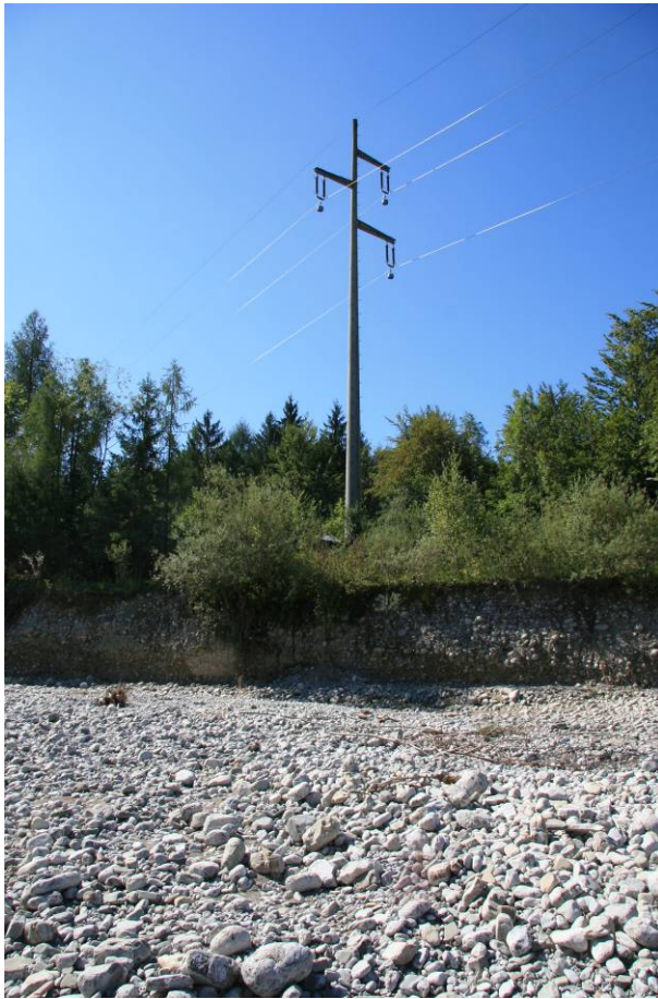
F56: Strommast- nur wenige Meter vom Uferanbruch entfernt – Maßnahmenvorschlag 2
