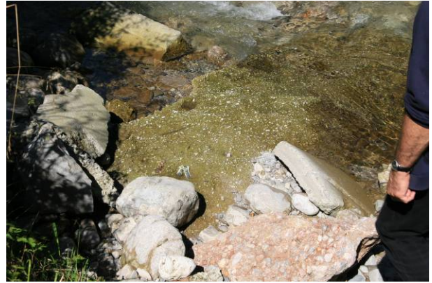
F73: betonummantelte Leitungsquerung unter der Autobahnbrücke – Funktion einer Sohlstabilisierung
