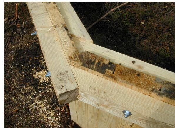
Bild 23: Draufsicht Detail - die ineinander greifenden NF-Bohlen sind beidseitig mit einem Kantholz gegen Ausweichen gesichert
