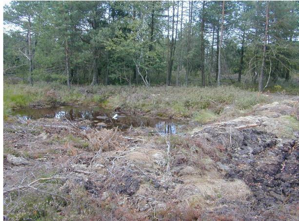
*Bild 25: Frisch abgedeckte Spundwand. Das Torfmaterial wird mit Moorsoden abgedeckt, um den Torf vor Erosion und Austrocknung zu schützen und die Begrünung des Dammes zu beschleunigen.*
