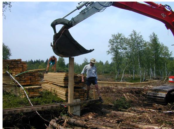
Bild 21: Eindrücken einer Nut-Feder-Bohle mit dem Bagger
