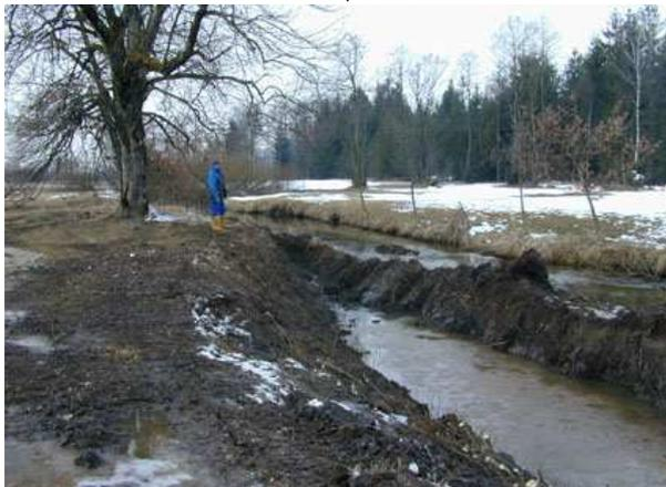
*Bild 9: Aushub im Bereich des neuen Bachbetts unter Erhaltung der alten Uferböschung*
