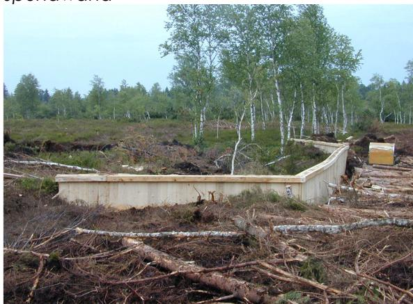
Bild 22: fertige Spundwand vor Abdeckung mit abgewinkelten Schenkeln zur besseren Einbindung ins Gelände
