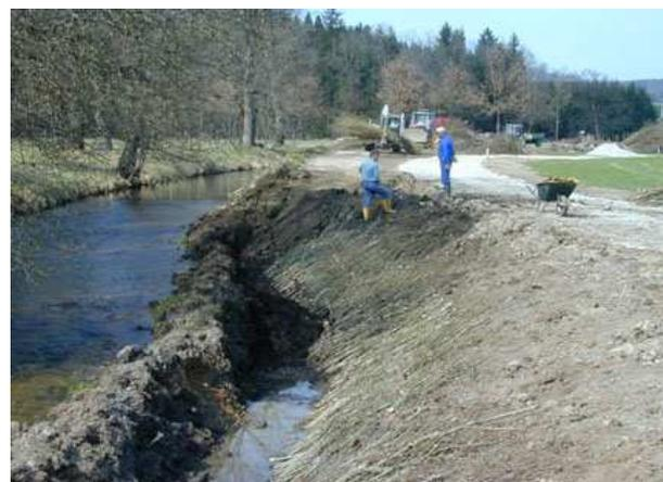
*Bild 10: Sicherung der neuen Uferböschung mit Weidenspreitlagen*
