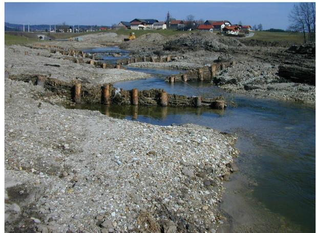
*Bild 14: Sohlrampe anstelle der früheren Betonsohlstufe; versetzt angeordnete Gurten aus Lärchenholzpiloten, die mit Weidenfaschinen verflochten wurden*
