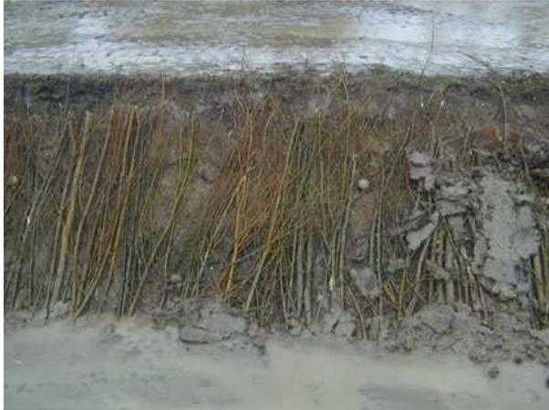
*Bild 11: Teilweise mit Humus abgedeckte Weidenspreitlagen in der Draufsicht*
