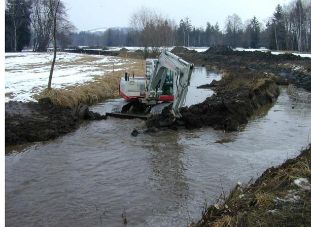
*Bild 12: Abtrag des Mittelriedels (alte Böschung) und Einbau des Materials am gegenüberliegenden Ufer als Vorschüttung*
