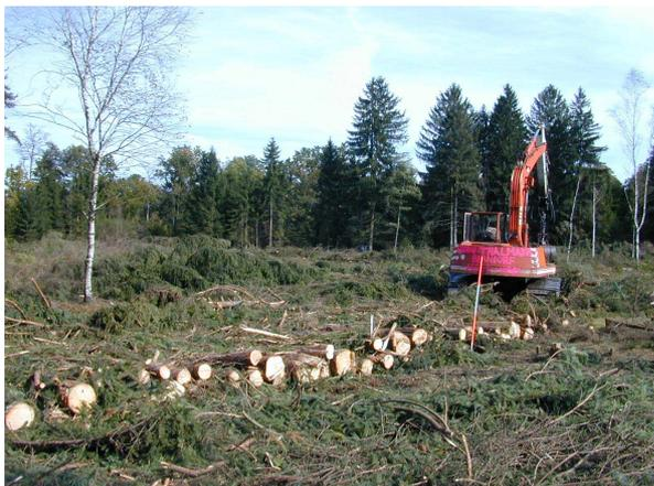
Bild 20: Arbeitsplattform aus geschichteten Stämmen unmittelbar unterhalb der geplanten Spundwand
