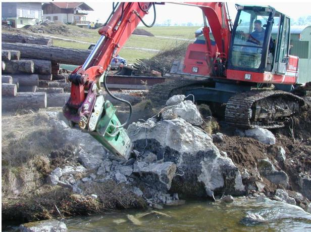
*Bild 13: Beseitigung der rund einen Meter hohen Betonsohlstufe mit dem Bagger*
