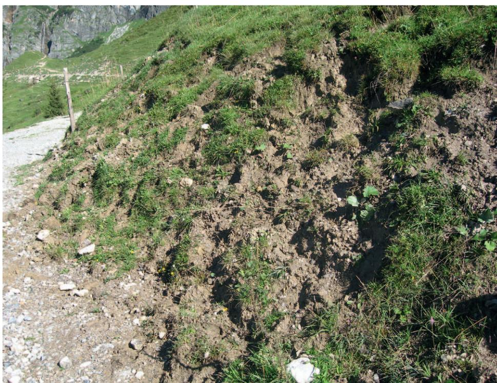
*Trittschäden durch Weidevieh an frischer Wegböschung: bei der Errichtung von Forst- und Güterwegen in beweideten Gebieten ist die rechtzeitige Auszäunung von Wegböschungen zur Gewährleistung des Begrünungserfolges einzuplanen (Bild: H. Hinterstoisser).*
