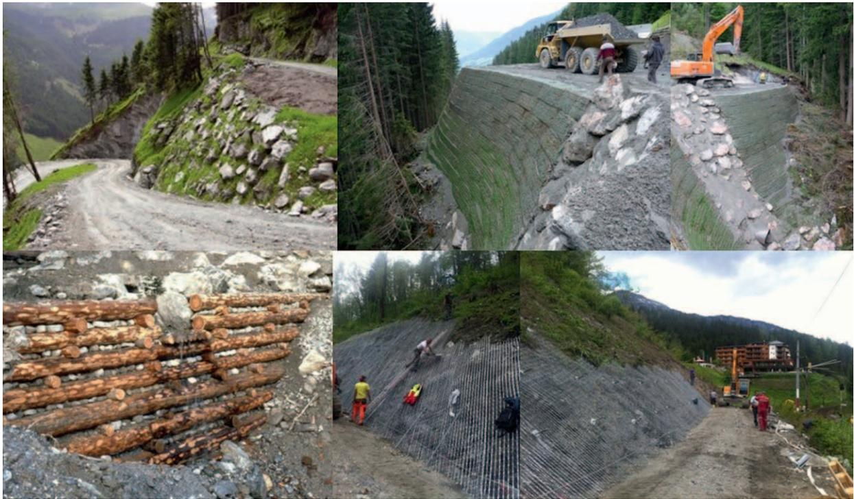
Abbildung 10: Bautechnik - Böschungssicherungen.
