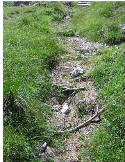
**Abb. 10** Bewährt hat sich die Abdeckung sanierter Abschneider mit Naturfasermatten. An Stellen vermehrten Wasserabflusses wird das Bodensubstrat zum Teil trotz Naturfasermatten verstärkt ausgewaschen und die Wiederbegrünerung erfolgt trotz fehlender Trittbelastung deutlich langsamer. (Fotos: G. Nowotny)
