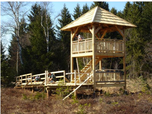
**Abb. 27** Barrierefreie Aussichtsplattform mit Bohlenweg am Rande des Hochmoors im Wengermoor (Foto: B. Riehl)
