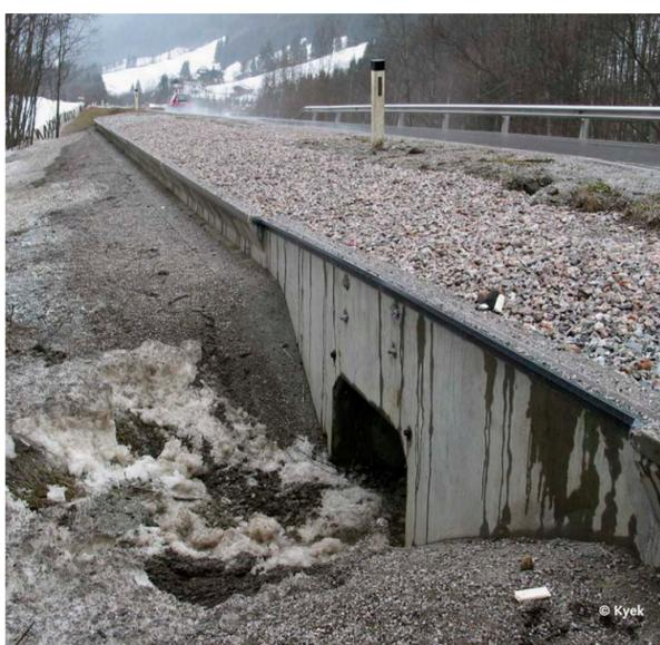
Tunnelleitanlage mit Unterführung zum Schutz von Kleintieren
