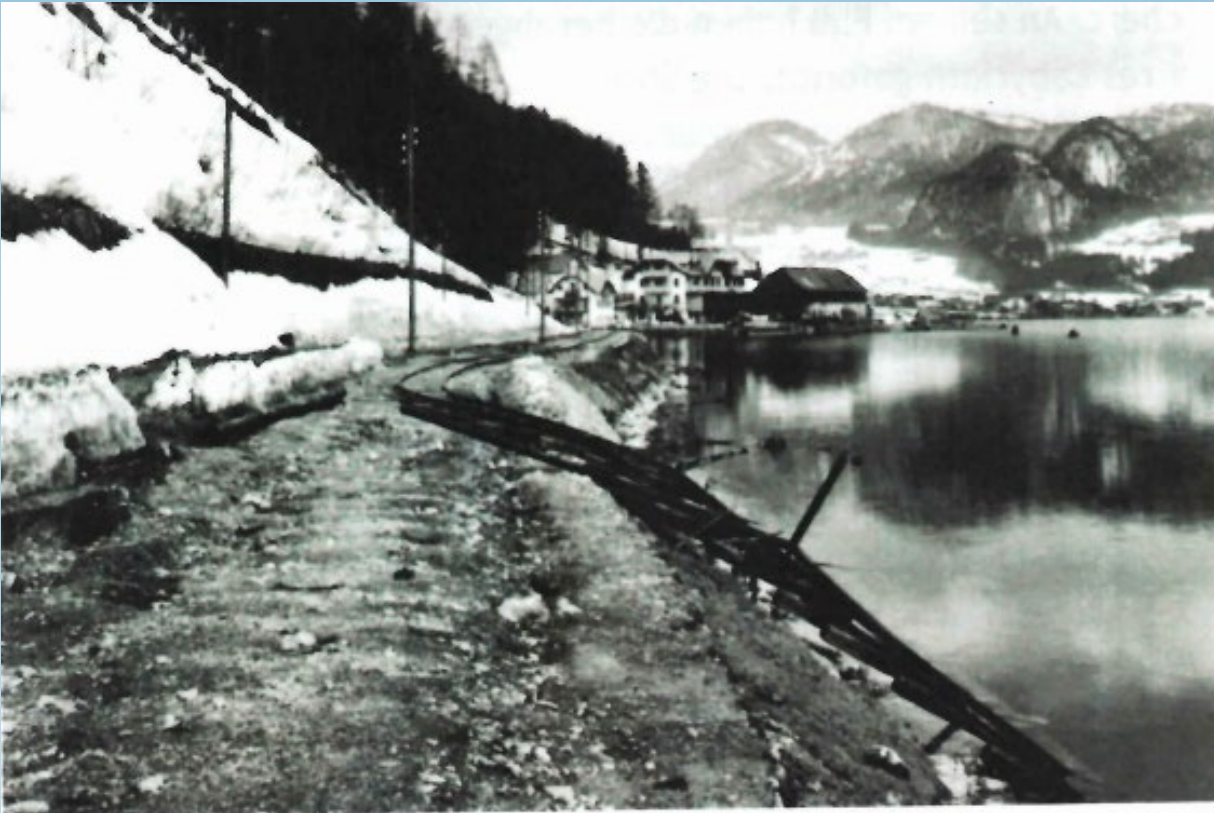
Der gewaltige Felssturz 1907 bei Lueg spülte auch die Gleise der Ischlerbahn in den Wolfgangsee.
