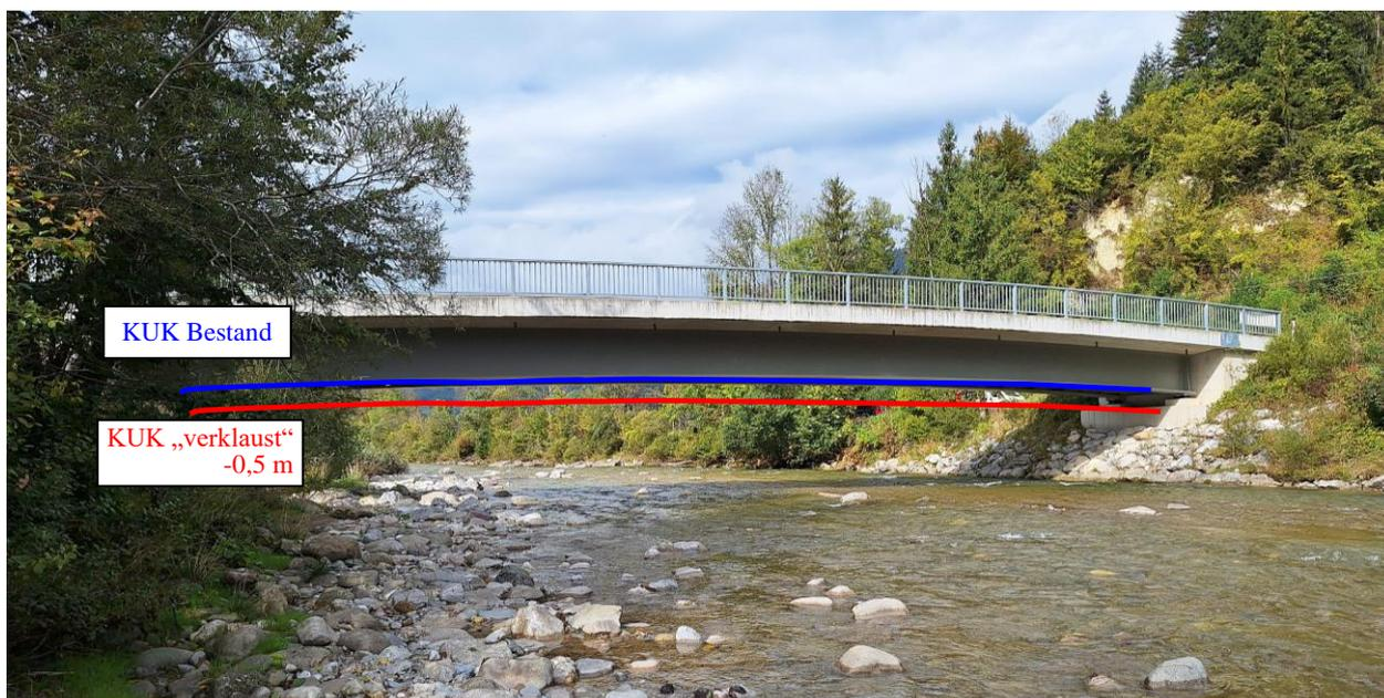
Abb. 7: Schematische Darstellung KUK-Absenkung bei Freibord < ca. 0,5 m
