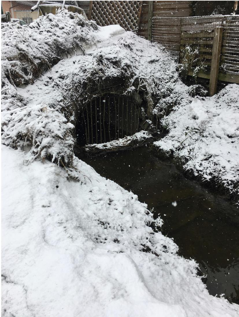
Abbildung 5: Annahme einer möglichen Verkläusung des Einlaufes der Verrohrungsstrecke Bruckbergkanal
