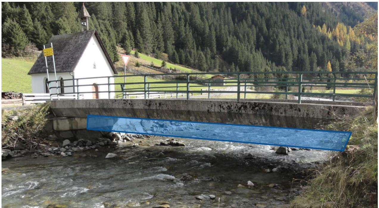
Abbildung 4: Annahme bei Brückenverklausungen. Die Reduktion des Abflussquerschnitts ist in BLAU dargestellt
