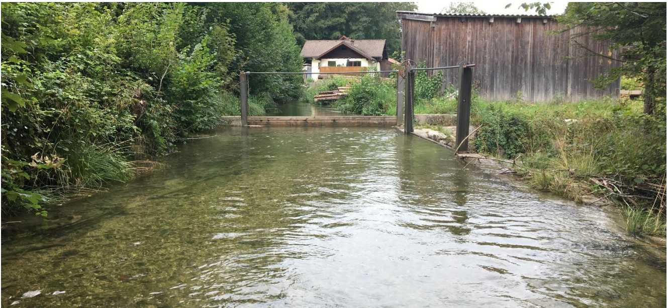
Abbildung 15: Wehrschieber KW Schöndorfer, Blickrichtung bachabwärts; oben: Werkskanal; rechts: Ausleitung Fuschler Ache
