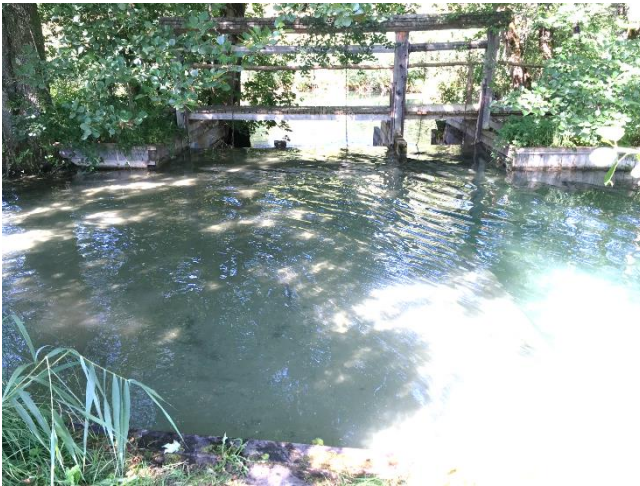
Abbildung 6: Wehrschieber Anlage Gössl mit Ausleitung in den Altarm der Fuschler Ache (oben); Beginn Werkskanal (Fließrichtung nach links)
