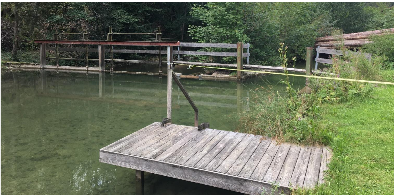
Abbildung 10: Wehranlage Enzinger, Blickrichtung bachab; Aufteilung in Fuschler Ache (links) und Werkskanal (rechts)
