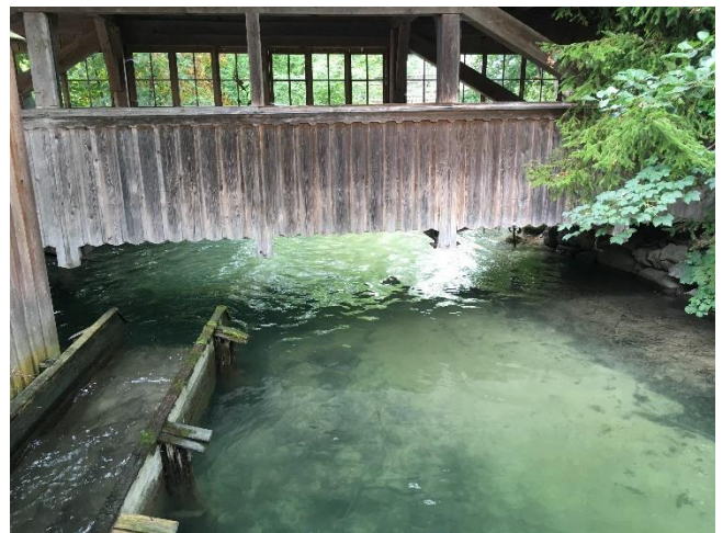
Abbildung 9: Auslauf Kraftwerksanlage Gössl unterhalb Holzbrücke
