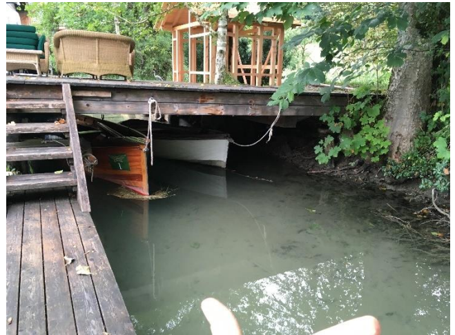
Abbildung 7: Steg über den Werkskanal bei KM 21,50
