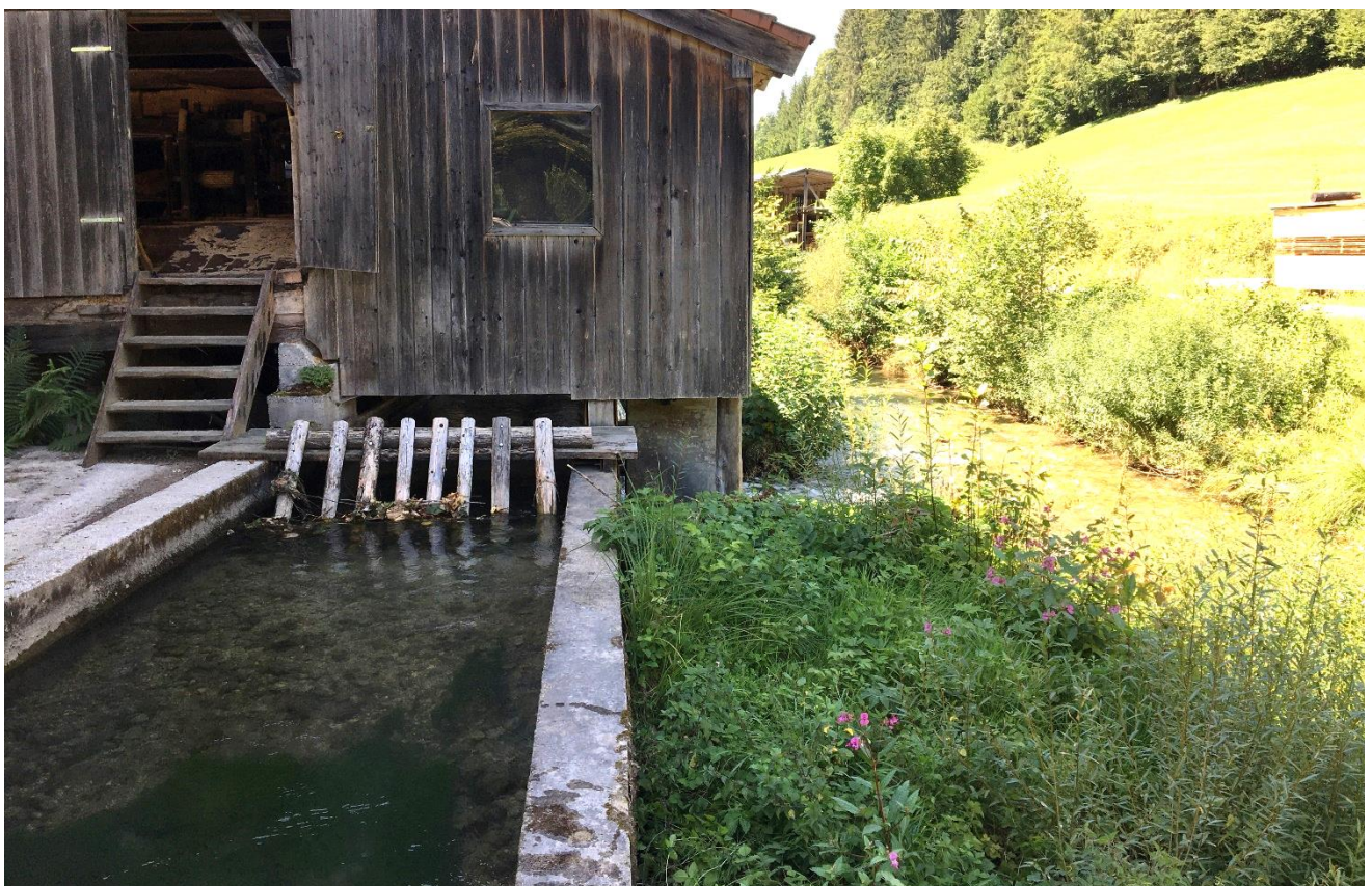
Abbildung 16: Zulauf Sägewerksanlage Schöndorfer; links: Werkskanal; rechts: Fuschler Ache
