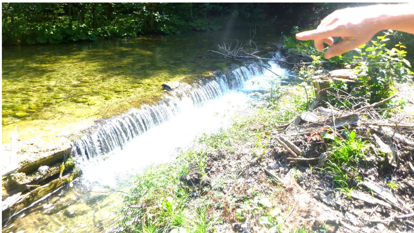
Abbildung 14: Streichwehr bei KM 19,61
