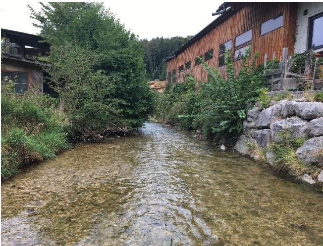
Abbildung 13: Grobsteinschichtung am rechten Ufer bei KM 20,35
