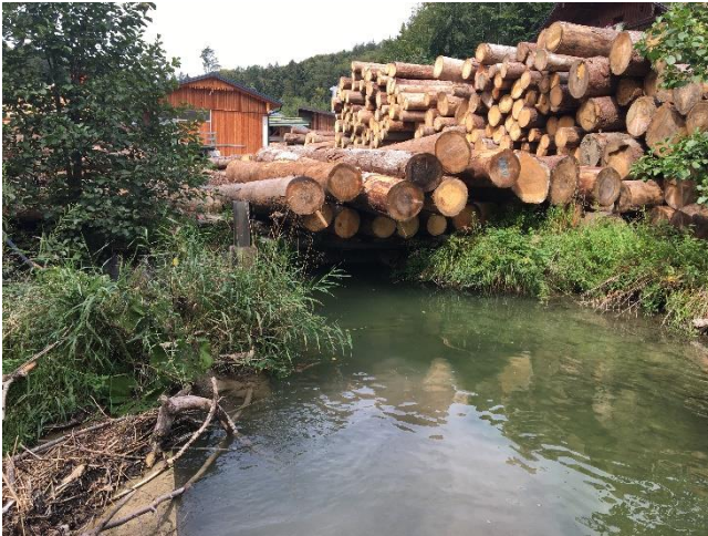
Abbildung 11: Zulauf Sägewerksanlage Enzinger mit Schütz (links)
