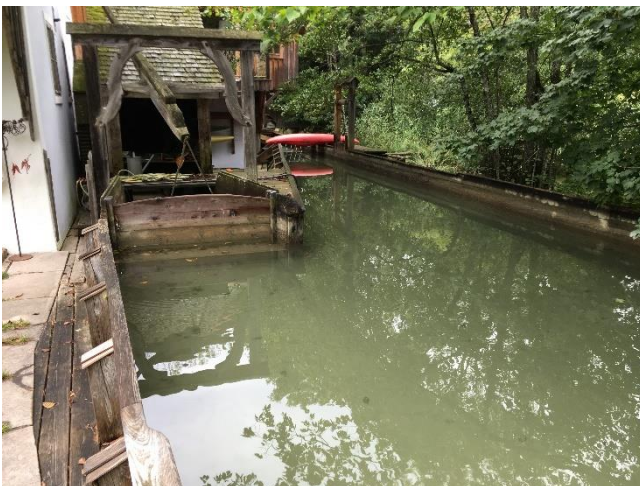
Abbildung 8: Zulauf Kraftwerksanlage Gössl
