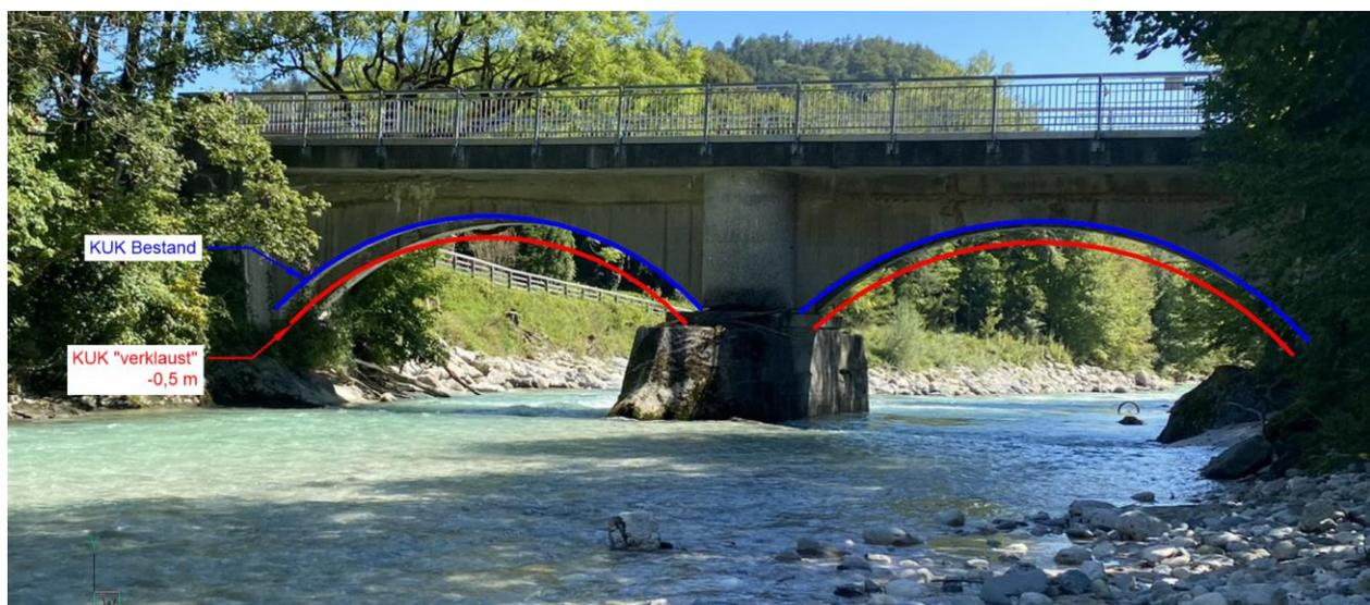
Abb. 7: Schematische Darstellung KUK-Absenkung bei Freibord < ca. 0,5 m am Bsp. GZP Königseeache
