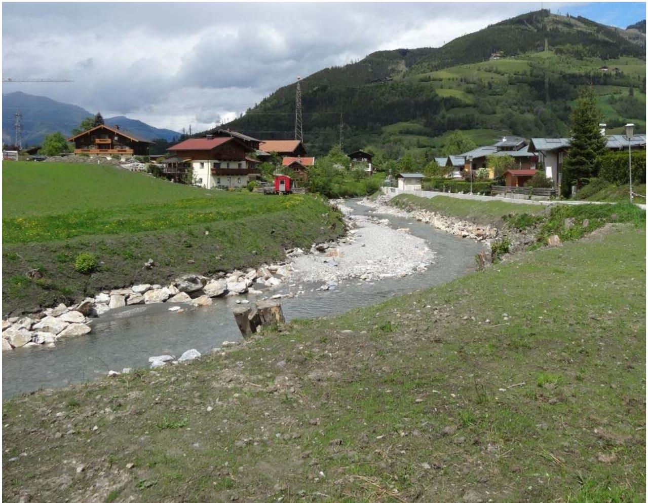
Abbildung 1: Aufweitung und Hochwasserschutzmauer – Fuscher Ache, Gemeinde Bruck
