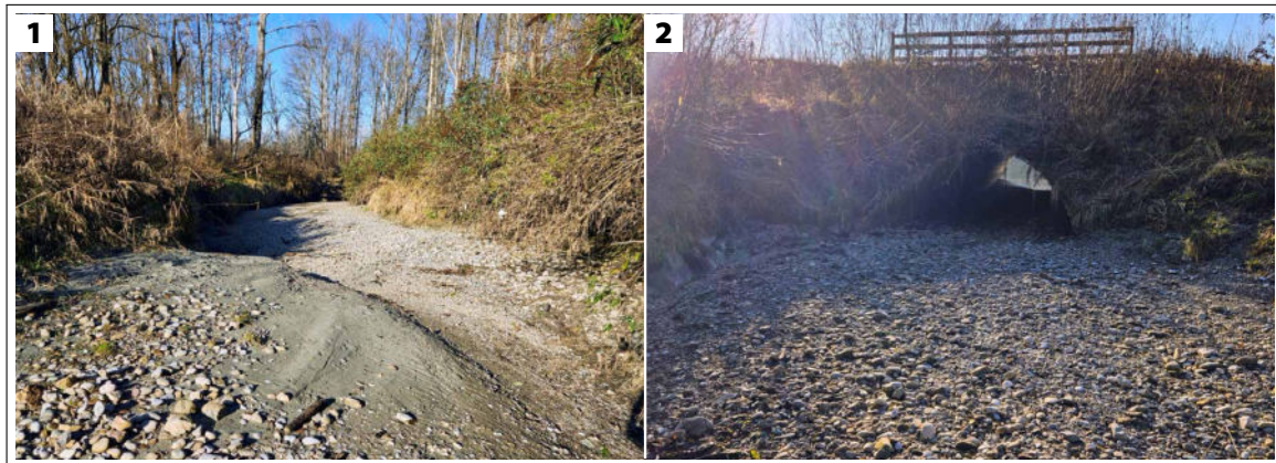
Abbildung 7.19: Bildtafel Ausleitung Salzach (FKM 52,0). 1 & 2: trockengefallener und stark zusedimentierter Rohrdurchlass sowie die Verbindungsstrecke zum Reitbach (25. November 2024). Original M. Burgschwai-ger.
