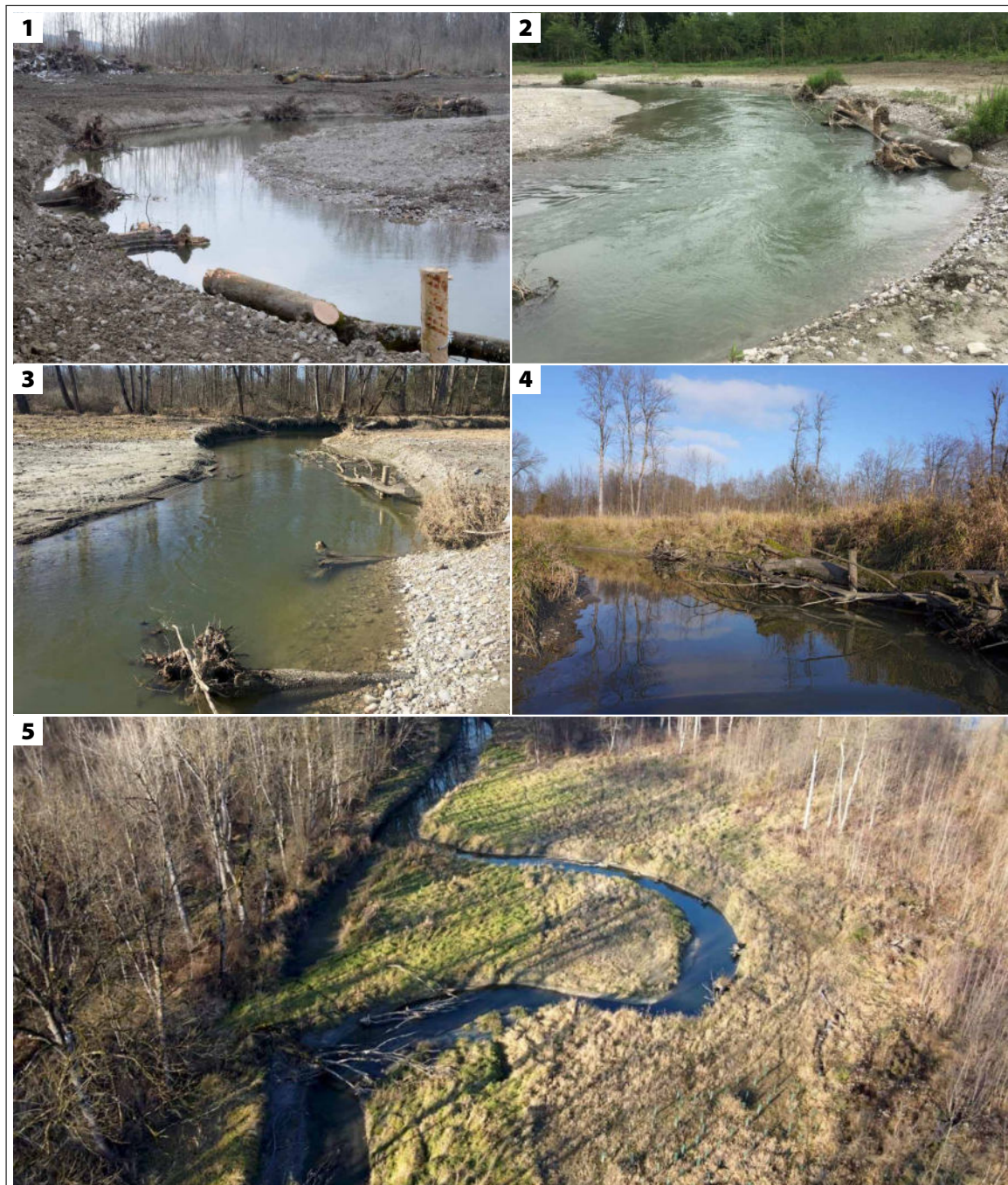
Abbildung 7.3: Bildtafel Hydromorphologie Reitbach SR 1 und SR 2 im Bereich der Vorlandabsenkung Nr. 1 — Teil 1. 1 : Maßnahme im Bauzustand (23. Februar 2018). Blickrichtung stromauf. 2 : Maßnahme kurz nach Baufertigstellung (12. Juni 2018). Blickrichtung stromab. 3 : Maßnahme am 25. Februar 2019. Erste Feinsedimentakkumulation am Gleithang. Blickrichtung stromab. 4 : Maßnahme drei Jahre nach Fertigstellung (25. November 2020). Blickrichtung stromauf. 5 : Luftbild der Maßnahme drei Jahre nach Fertigstellung (25. November 2020). Blickrichtung stromab. Alle Bilder Originale Zauner u. a. (2021a) .
