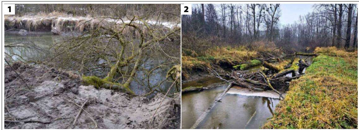
Abbildung 7.9: Bildtafel Hydromorphologie Reitbach mit SR 7 und SR 8. 1 : Maßnahme während der Bauarbeiten (19. Februar 2018). Blickrichtung stromauf. Original Zauner u. a. (2021a) . 2 : Maßnahme sieben Jahre nach Fertigstellung (25. November 2024). Totholzansammlungen im Bereich der Strukturierungsmaßnahmen SR 7. Blickrichtung stromab. Original M. Burgschwaiger.
