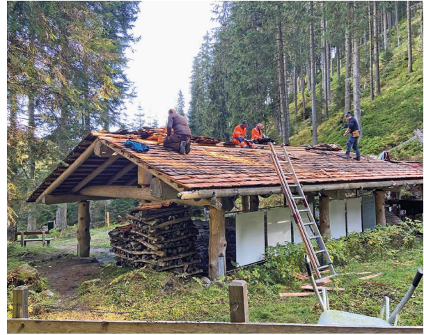
Das Dach der Schmelzhütte in der Knappenwelt Angertal wurde mit neuen Lärchenschindeln gedeckt. Foto: Walter Wihart / Via Aurea
