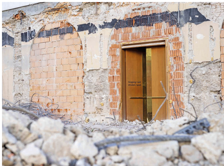
Baustelle Neue Residenz. Im zweiten Innenhof haben die Arbeiten für die Errichtung des „Belvedere Salzburg“ begonnen.
