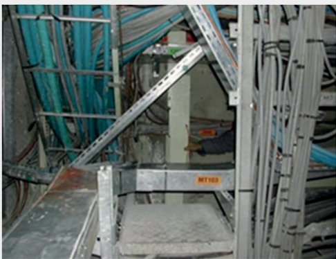
Hinzufügen von Halterungen für die Kabelkanäle
