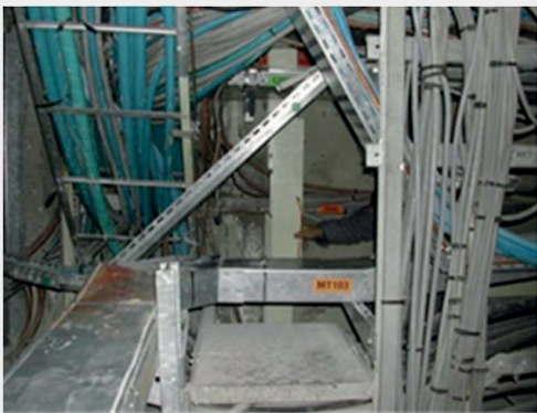
Hinzufügen von Halterungen für die Kabelkanäle
