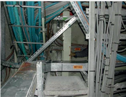
Ajout de supports pour les chemins de câble
