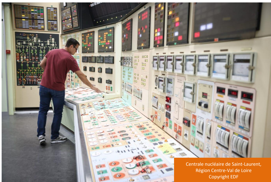
Figure 18. Salle de commande d'un réacteur 900 MWe
