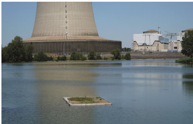
Gravière installée sur le plan d'eau
