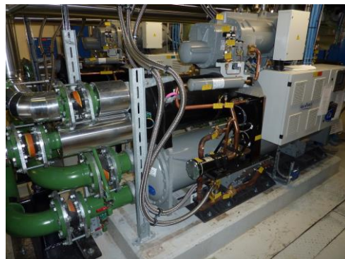
Nouveau groupe froid (+ 50% de capacité frigorifique)
