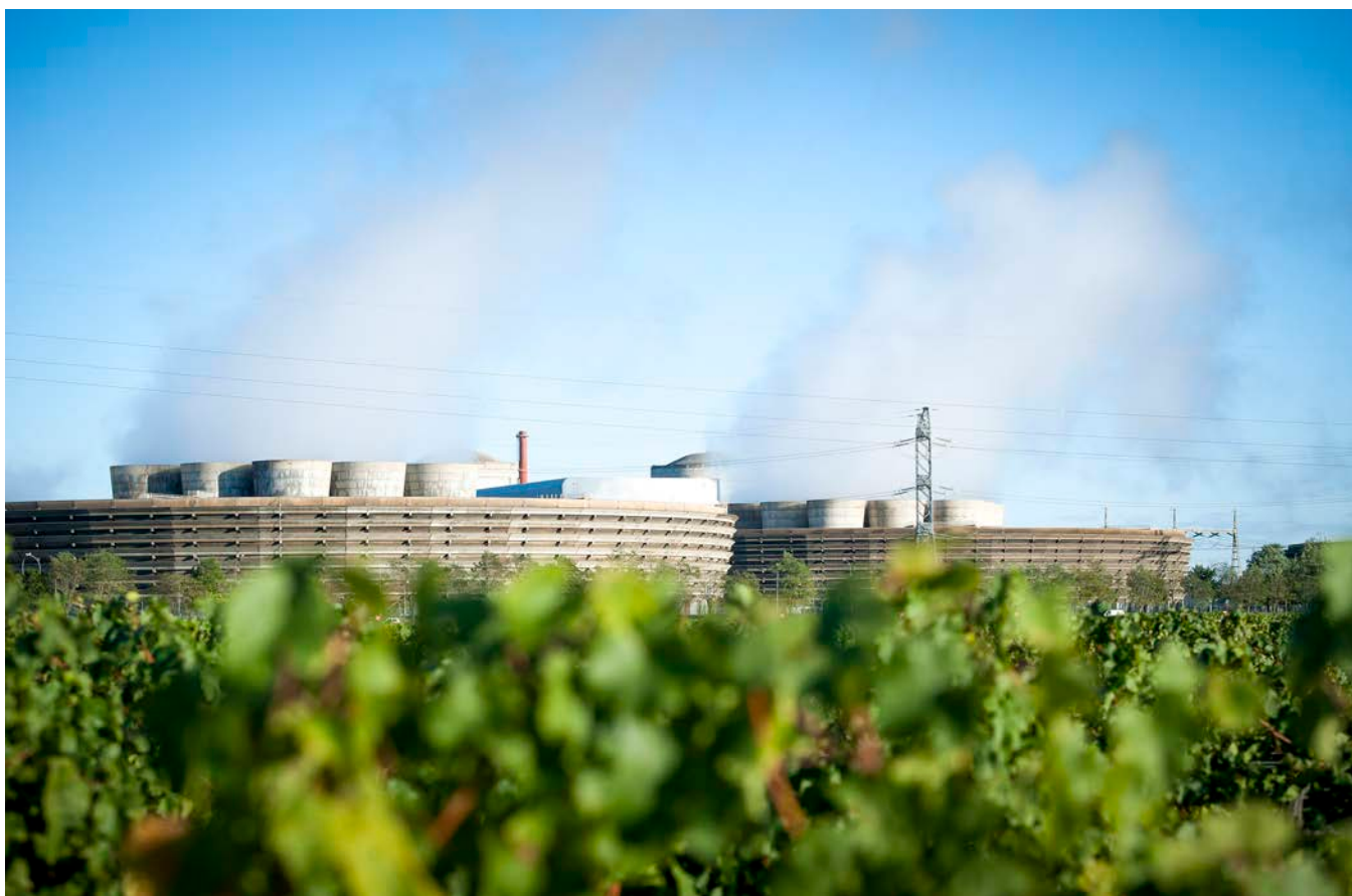
Centre Nucléaire de Production d'Électricité de Chinon.
