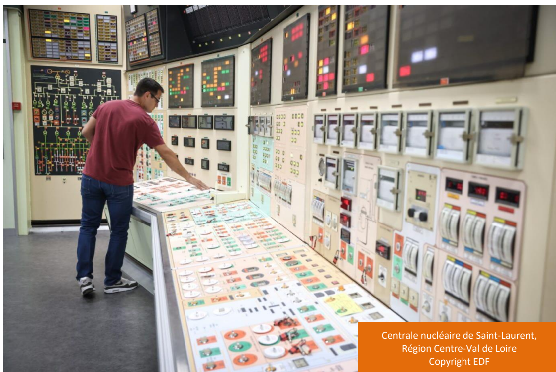
Figure 18. Salle de commande d'un réacteur 900 MWe
