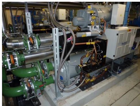
Nouveau groupe froid (+ 50% de capacité frigorifique)
