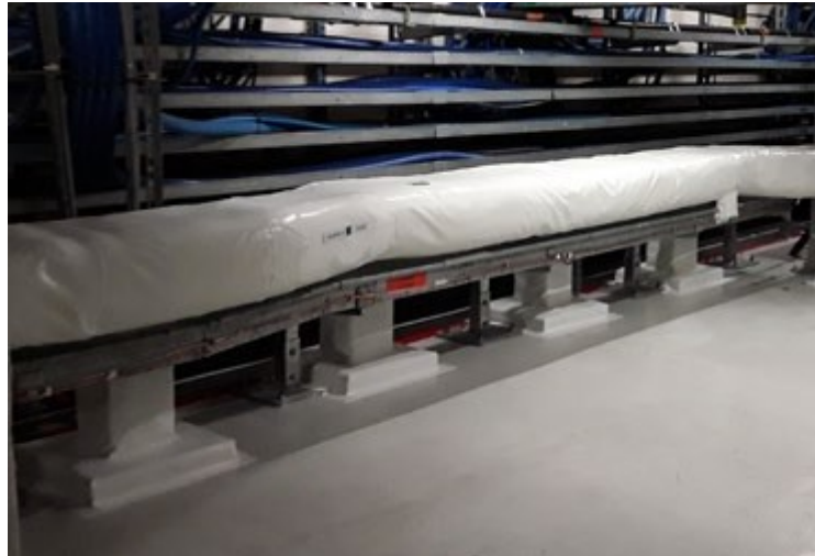
Abbildung 6. Beispiel für den Schutz eines Kabelkanals
