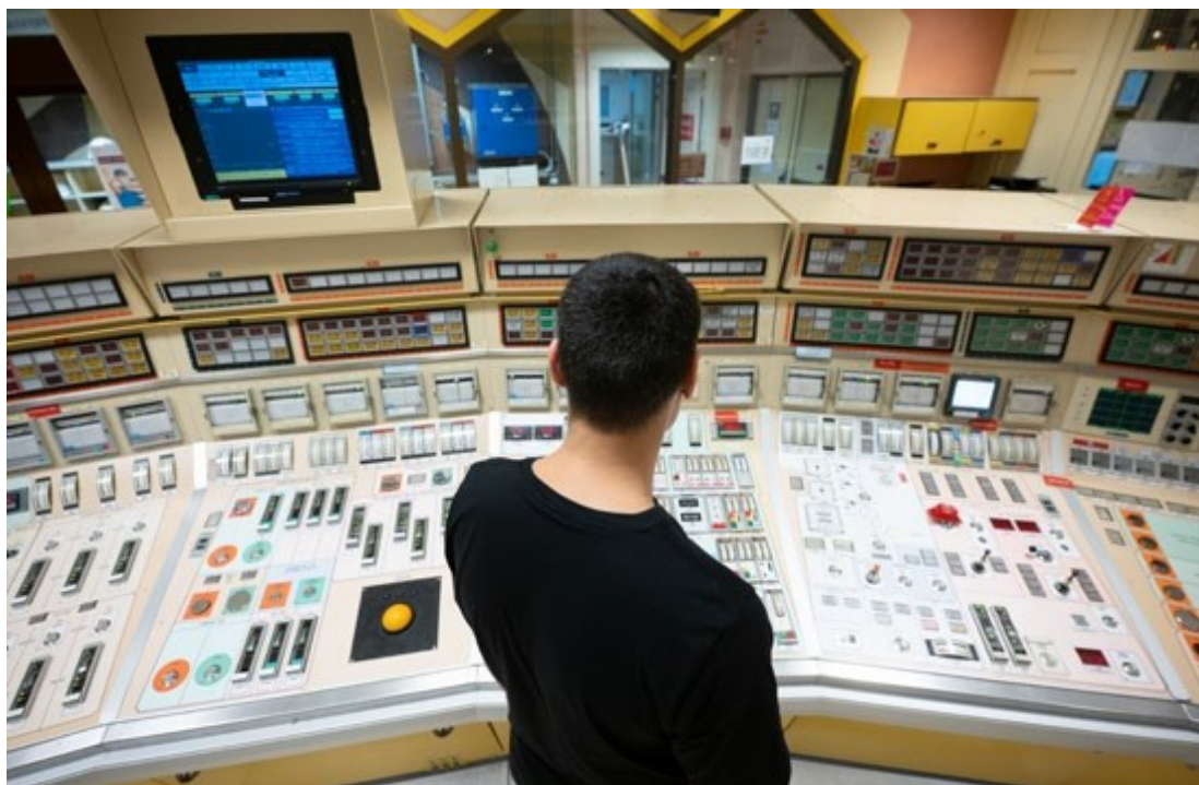
Abbildung 21. Kontrollraum eines 900-MWe-Reaktors (Copyright EDF / DAMPIERRE / Romain BEAUMONT)
