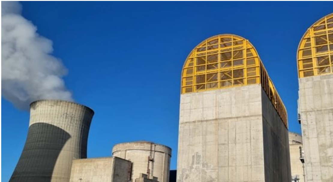
Notfall-Dieselaggregate (DUS) für die Reaktoren Nr. 3 und Nr. 4
