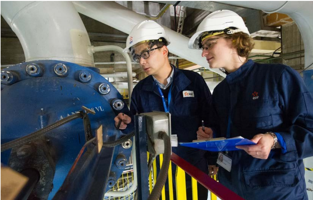
Techniken der Halleninspektion der „Anlagen im Kernkraftwerk zur Stromerzeugung in Le Bugey.
