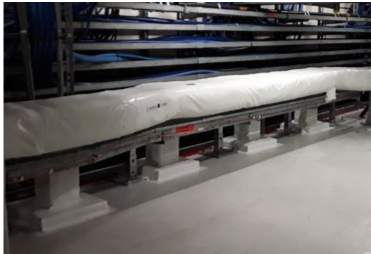
Abbildung 6. Beispiel für den Schutz eines Kabelkanals
