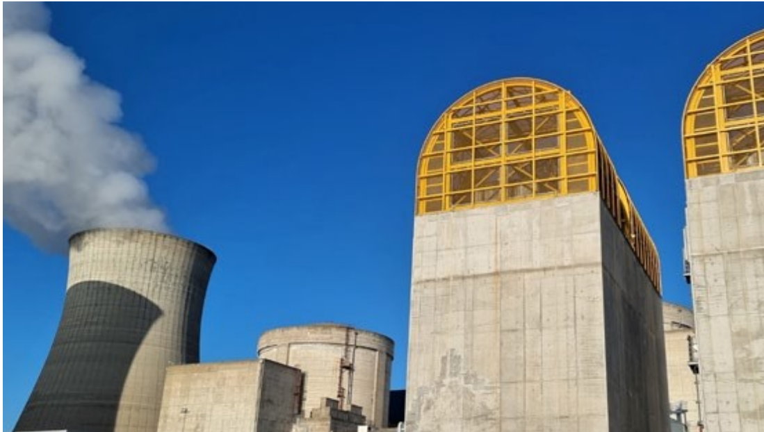
Notfall-Dieselaggregate (DUS) für die Reaktoren Nr. 3 und Nr. 4
