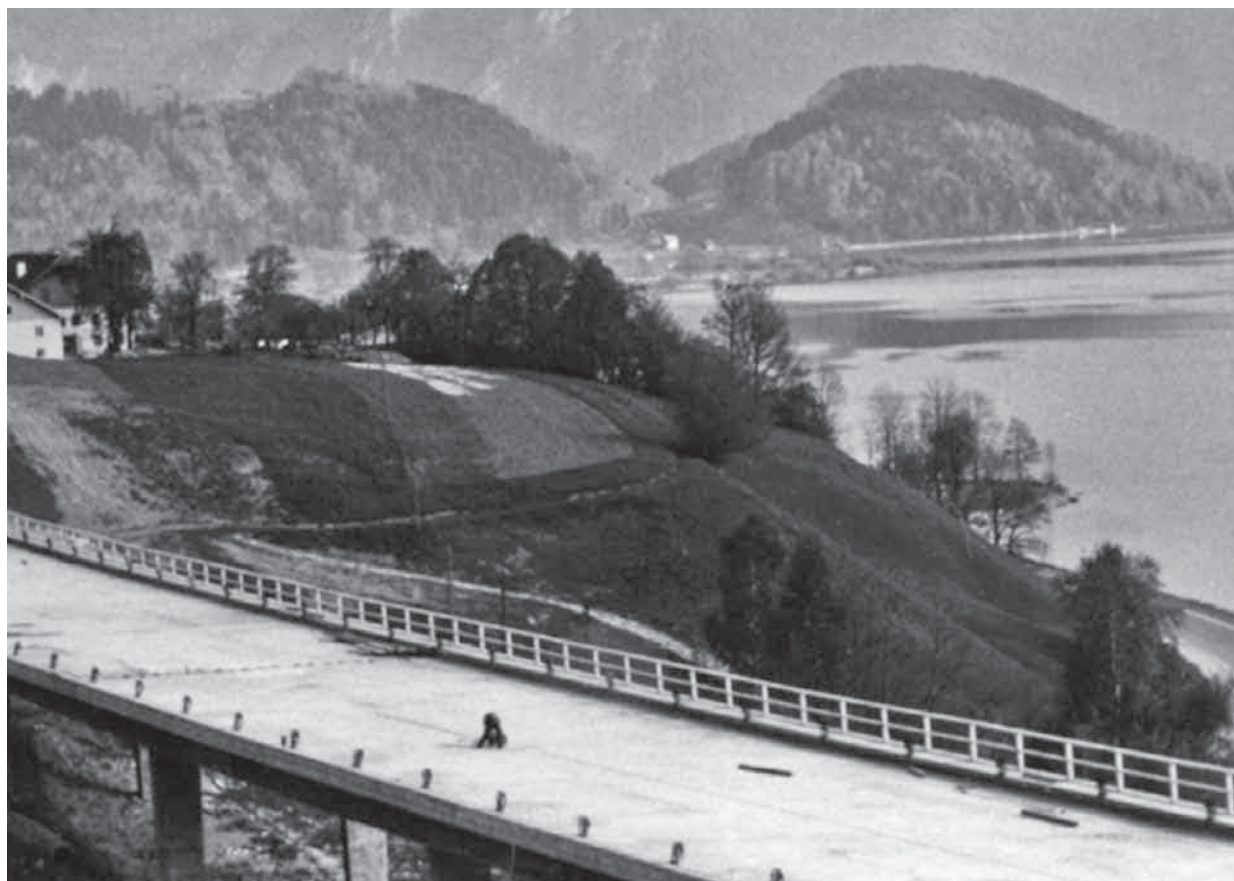
Abb. 114 Westautobahn bei Mondsee; Baufortschritt im Mai 1963.
