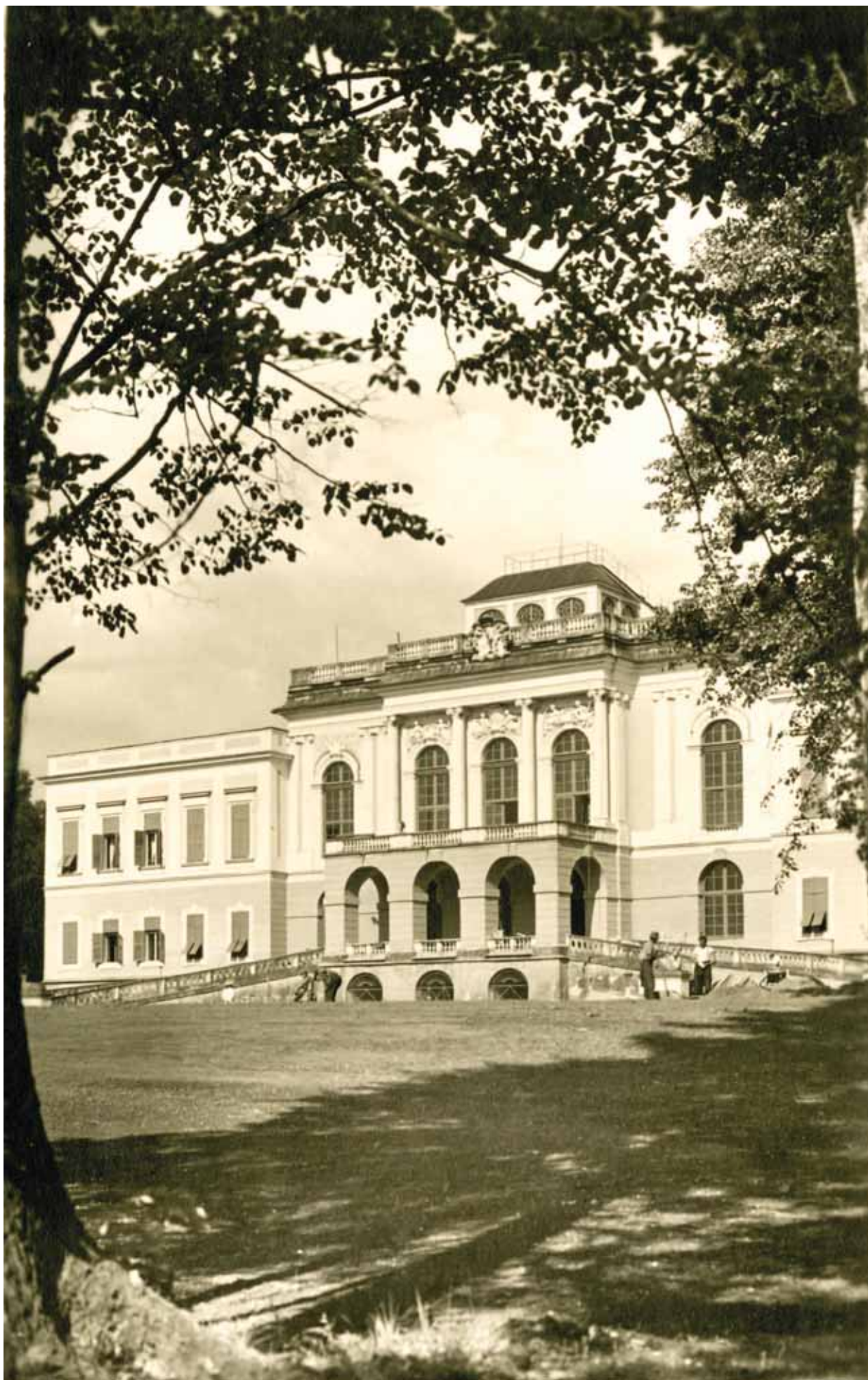
Abb. 102 Schloss Kleßheim 1938 vor dem Umbau.
