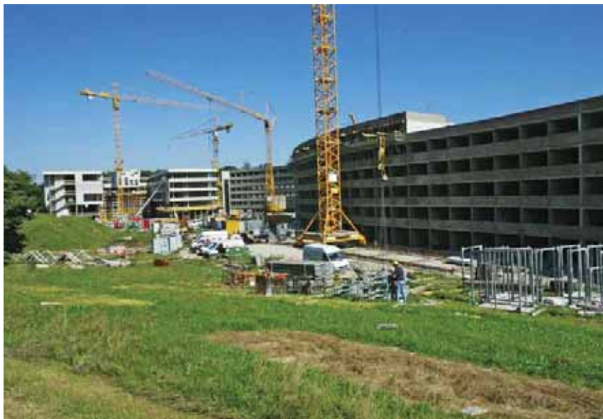
Abb. 133 Die Baustelle der Fachhochschule Urstein im September 2004.
