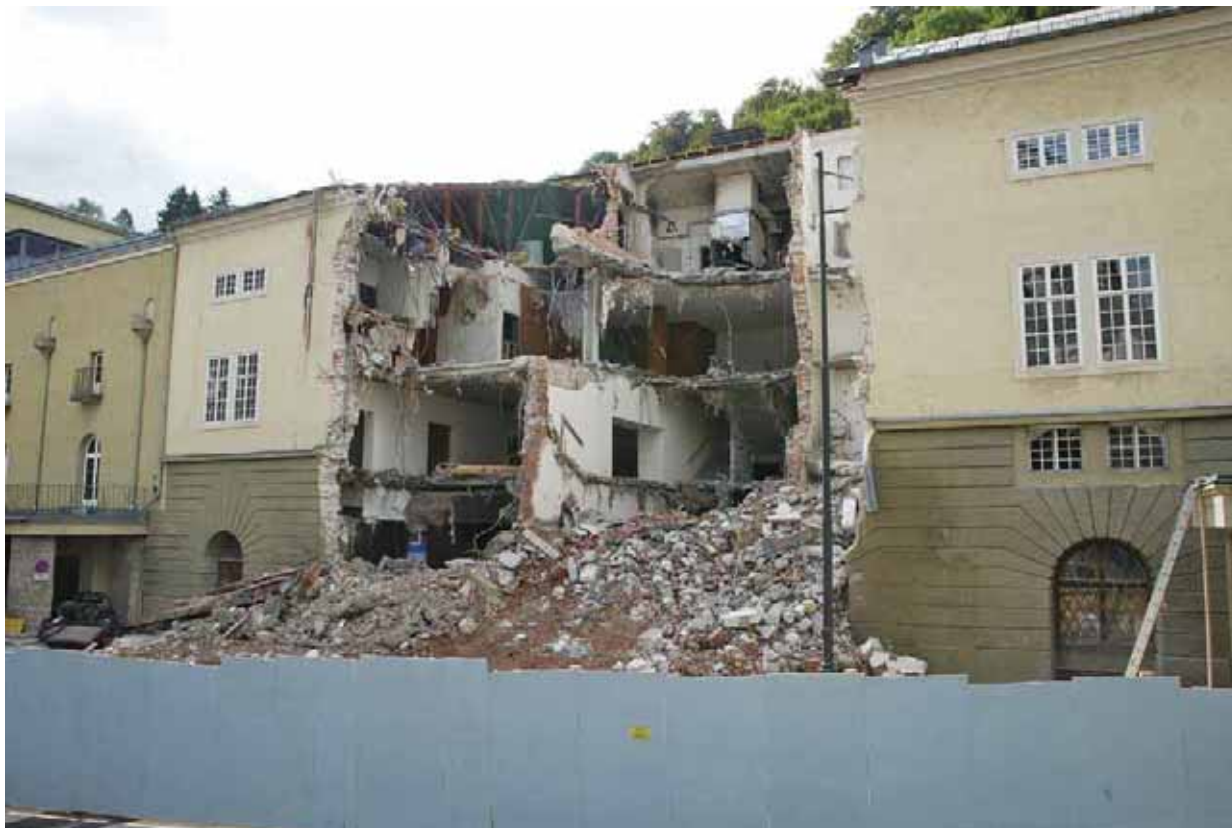
Abb. 138 Im Herbst 2004 begann der Abriss des Kleinen Festspielhauses. Das neue „Haus für Mozart“ wurde im Sommer 2006 eröffnet.
