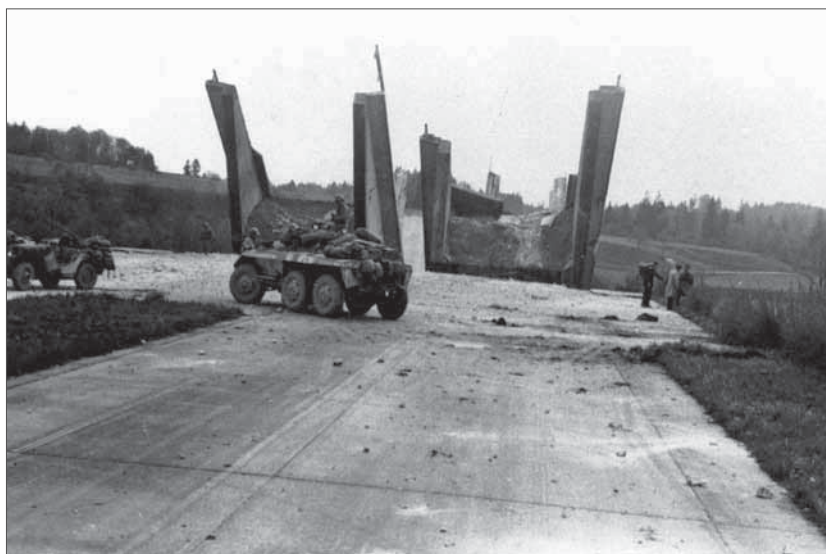
Abb. 105 US-Amerikanische Einheiten am 4. Mai 1945 vor der zerstörten Autobahnbrücke bei Piding.
