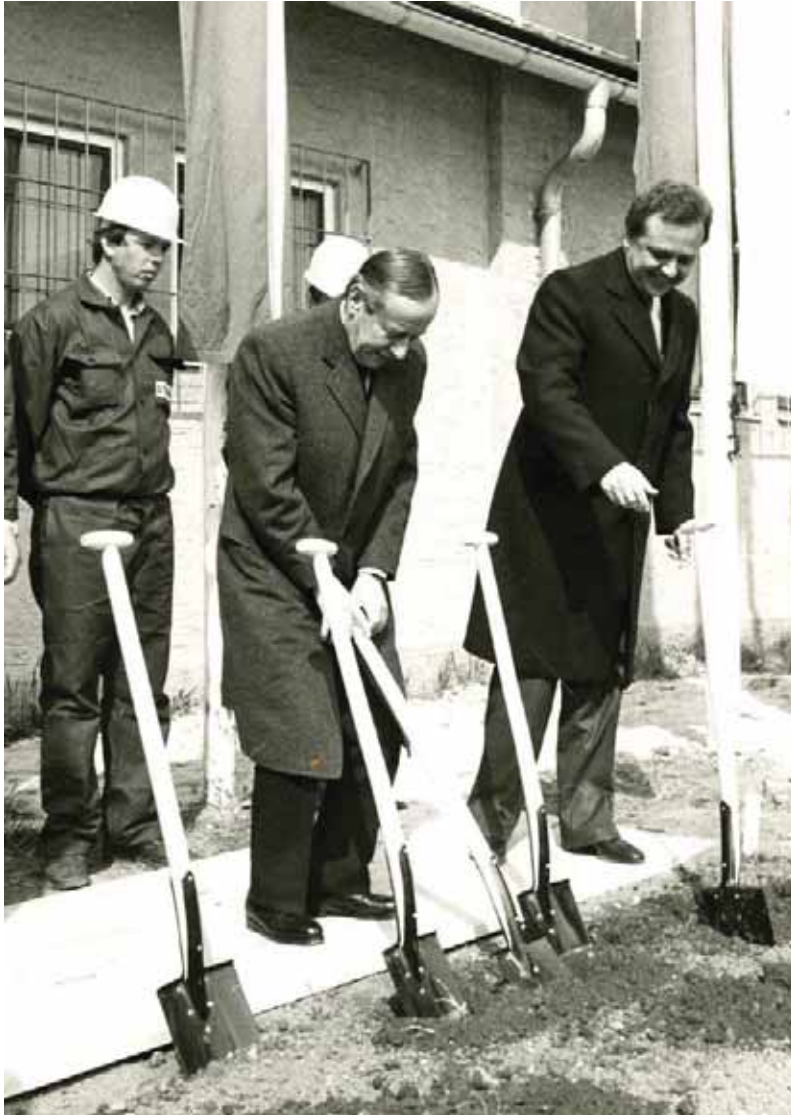
Abb. 129 Landeshauptmann Wilfried Haslauer (links) und Landeshauptmann-Stellvertreter Wolfgang Radlegger beim Spatenstich für den Neubau der Naturwissenschaftlichen Fakultät, 21. April 1982.
