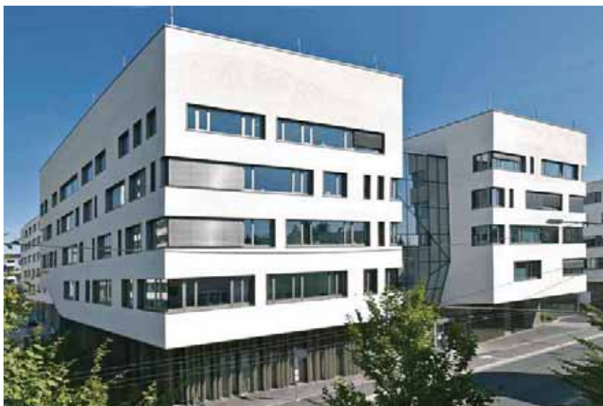
Abb. 134 Das neue Forschungs- und Lehrgebäude der PMU.
