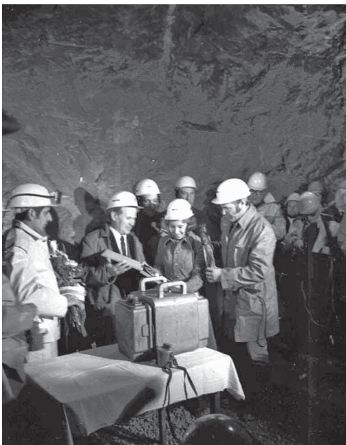
Abb. 115 Symbolische erste Sprengung für den Katschbergtunnel, 28. Jänner 1971.
