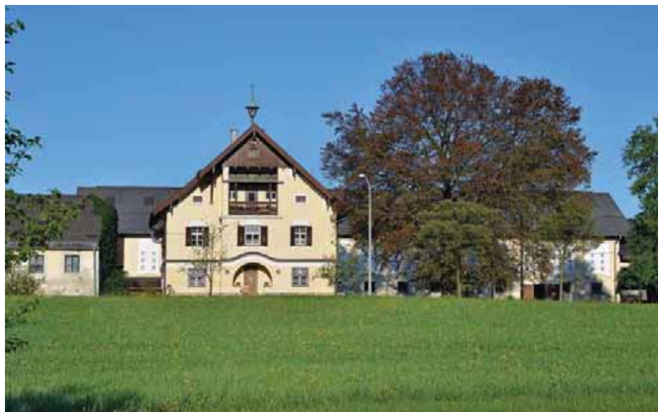
Abb. 148 Der Erentrudishof in der Morzger Straße.
