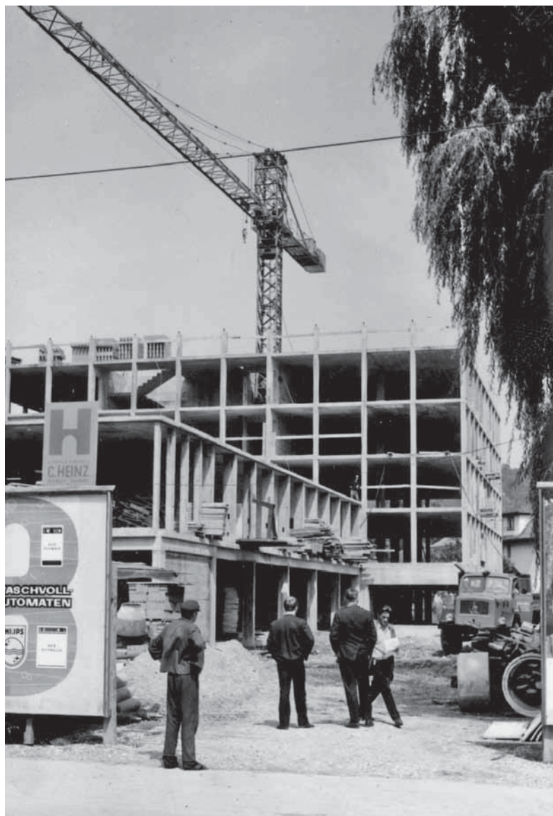
Abb. 124 Die Baustelle des Salzburger Landesarchivs im Jahr 1970.
