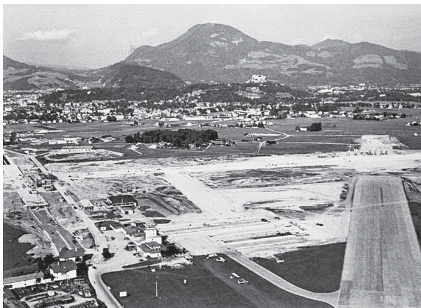
Abb. 117 Bauarbeiten für die Verlängerung und Neuausrichtung der Start- und Landebahn des Salzburger Flughafens.
