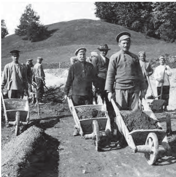
Abb. 100: Russische Kriegsgefangene beim Bau der sogenannten „Russenstrasse“ in Thalgau. (Foto: Archiv Bernhard Iglhauser).
