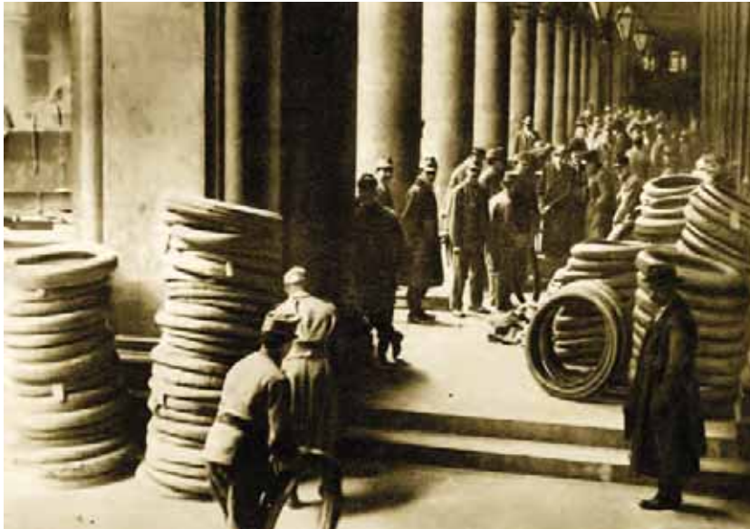
Abb. 92: Ablieferung der requirierten Autoreifen in der Vorhalle des Wiener Rathauses. (SLA, HS 2364: „Das interessante Blatt“, 21. 10. 1915, S. 12; Reproduktion: SLA).
