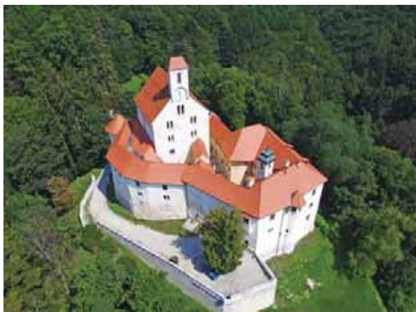
Abb. 15: Die aufwendig restaurierte Burg Pischätz harrt einer neuen Nutzung (Foto: Sašo Panić, ETREND d.o.o.).
