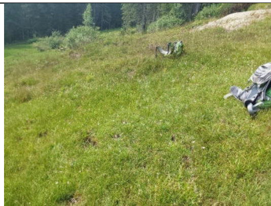
Abbildung 116 FFH-LRT 7230, Hanglage, Blickrichtung West, stark durch Drainagen beeinträchtigt, angrenzend Hangrutschung
