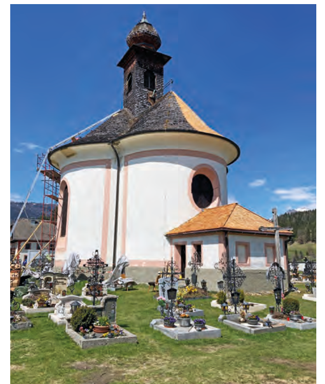
Halbzeit bei den Sanierungsmaßnahmen an der Filialkirche Althofen bei Mariapfarr.
