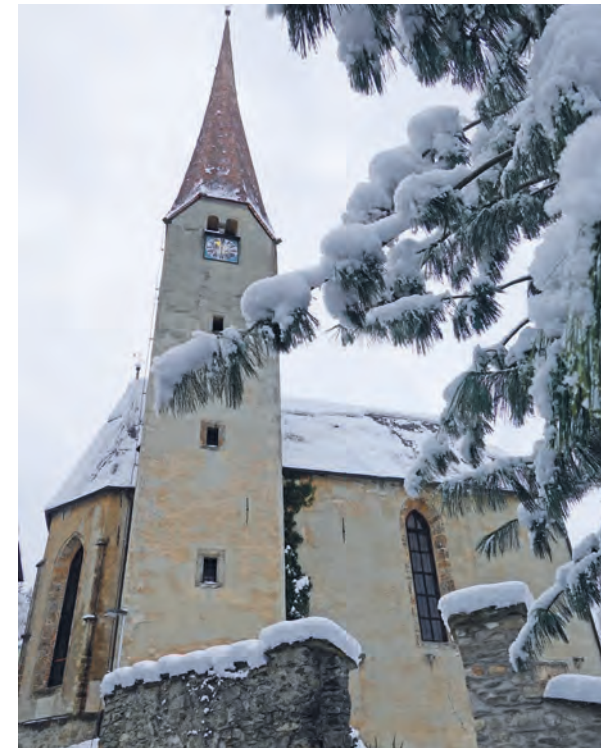
Bei der Nikolauskirche in Bad Gastein standen Sanierungsarbeiten an Fenstern und Dach an. Fotos (4): Land Salzburg/Scheutz
