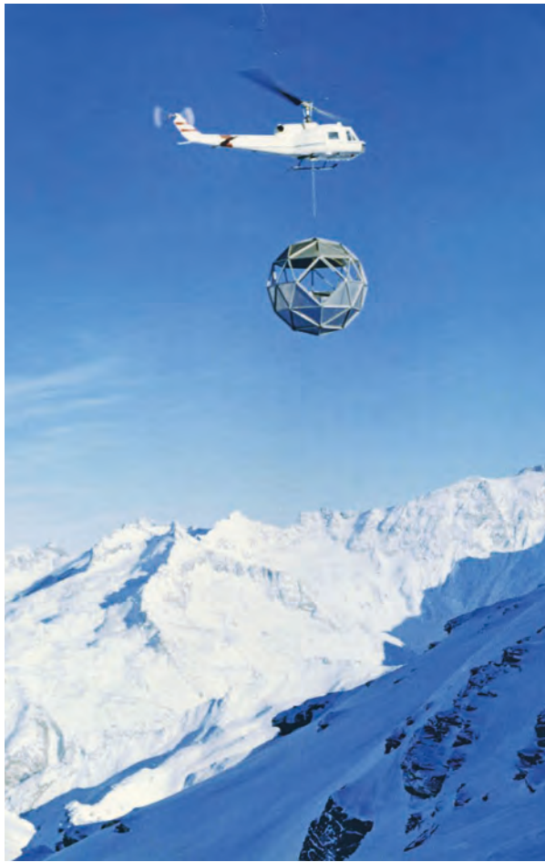
Gerhard Garstenauer, Sphärischer Kugelbau für Schilftstationen in Sportgastein von Helikopter zum Zielort geflogen (1972, Fotoabzug auf Papier). Foto: Salzburg Museum
