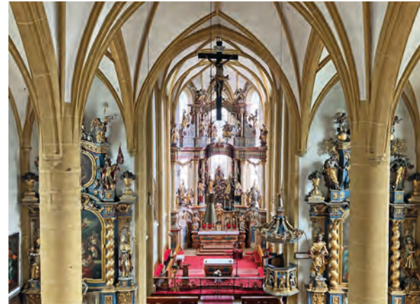
Das Innere der Pfarrkirche Bad Hofgastein wird in den nächsten Jahren saniert. Fotos (7): Land Salzburg/Claudia Scheutz
