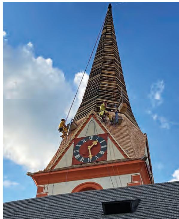
Der Turm der Pfarrkirche St. Margarethen im Lungau wurde neu eingedeckt.
