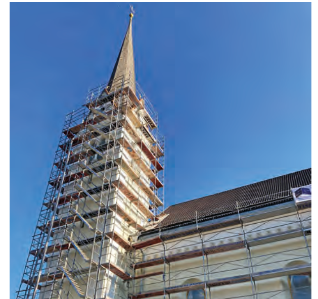
Bei der Pfarrkirche in Hollersbach im Oberpinzgau wurde die komplette Fassade erneuert.
