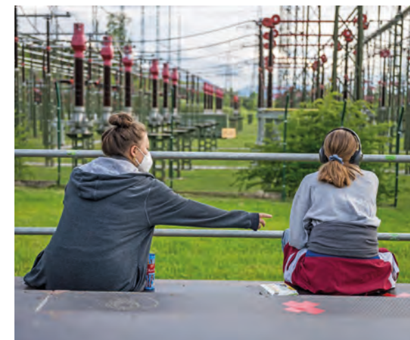
Clemens Mairhofer machte beim Umspannwerk in Elixhausen elektrische Infrastruktur hörbar. Foto: Alber Moser
