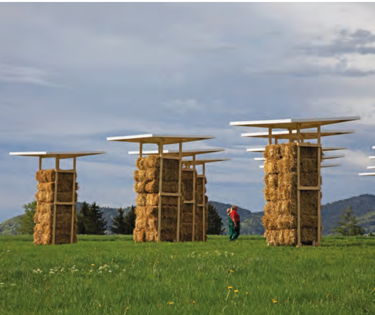
Eine Arbeit zwischen Architektur, Urbanismus, bildender Kunst und Design: Der „Superort“ von Clemens Bauder und Construct Lab. Foto: Supergau
