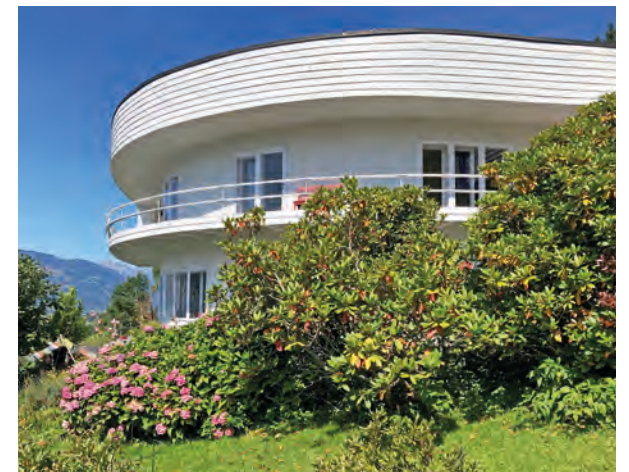
Gefördert wurden auch Sanierungsarbeiten am Haus Heyrowsky in Thumersbach, das in den 1930er-Jahren nach Plänen von Lois Weizenbacher errichtet worden war.
