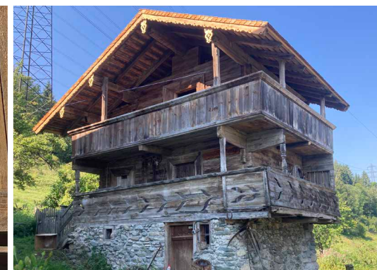
Beim 1708 erbauten Getreidekasten des Hummersdorfer Unterbergbauern wurde die Lärchenschindeleindeckung erneuert. Foto: Land Salzburg/ Claudia Scheutz
