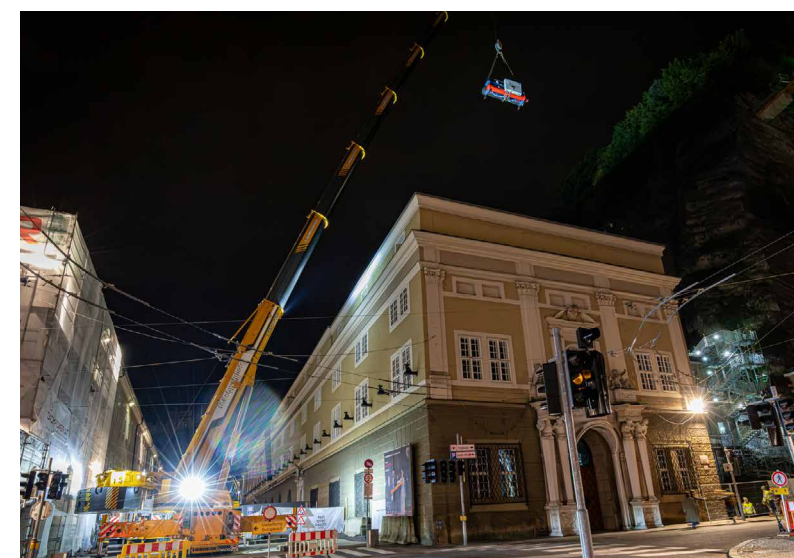
Die Kältemaschine „schwebte“ von ihrem Standort in einer Mönchsberg-Kaverne in den neuen unterirdischen Raum neben dem Großen Festspielhaus. Foto: FSB 2030/Stefan Zauner, 2025
