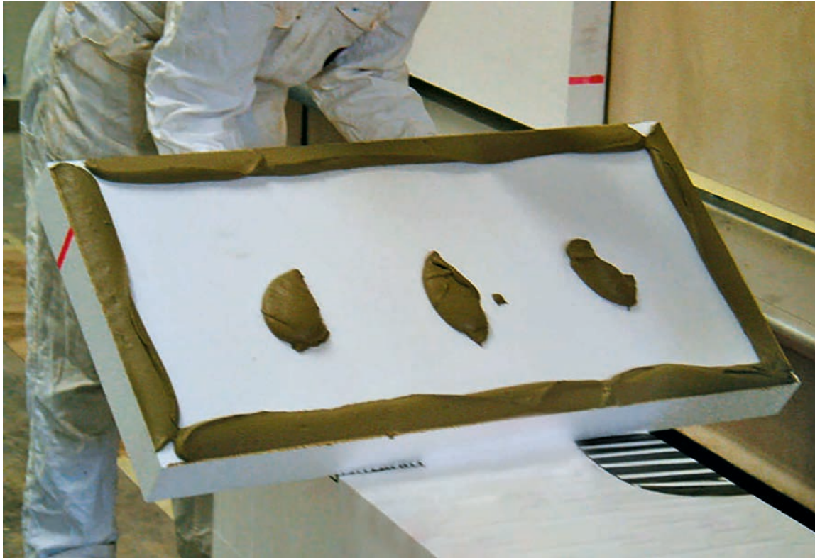
Kleberauftrag (Bautechnische Versuchs- und Forschungsanstalt Salzburg)
