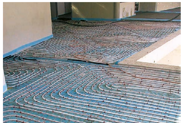
Fußbodenheizung (Energieberatung Salzburg)
