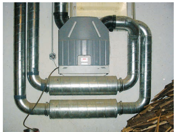
Lüftungsgerät mit Wärmetauscher und Schalldämpfer (DI Andreas Greml)
