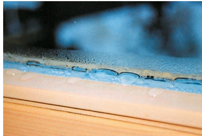
Kondenswasser im Randbereich bei Fenstern mit Glasrandverbund aus Aluminium (Fa. Swisspacer)
