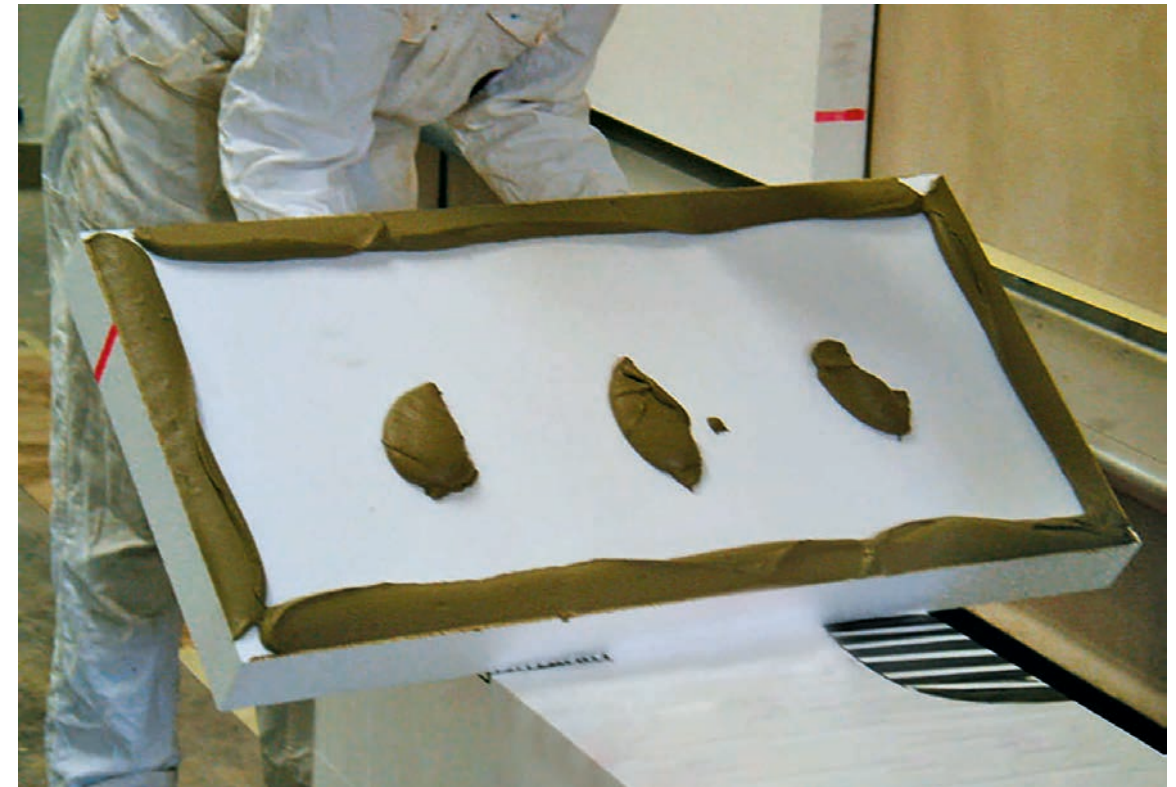
Kleberauftrag (Bautechnische Versuchs- und Forschungsanstalt Salzburg)
