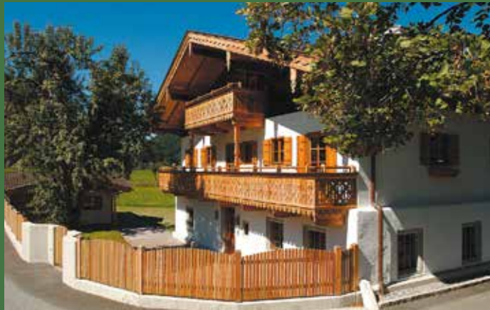
Sanierung in St. Martin. Fotos: Klaus Bauer
