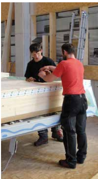
Abb. Wandvorfertigung im Holzbaubetrieb
