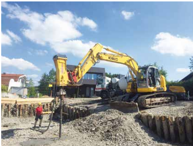
FOTOS: SCHMIDLECHNER BAU
