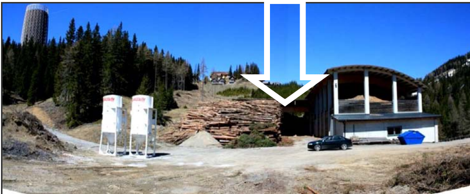
BIOHEIZWERK ASTRA, BLICKRICHTUNG NORDEN
