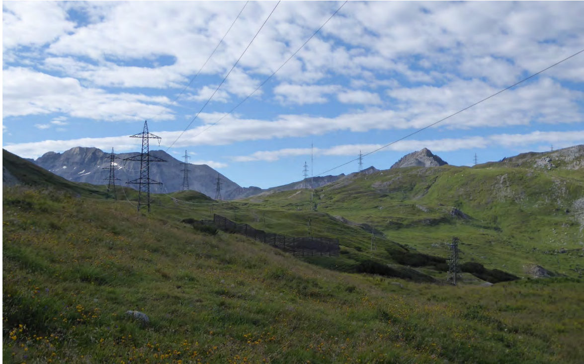
Abbildung 101: Blick vom Zustieg Südwiener Hütte vom Nordrand des Standortraumes übers Windsfeld Richtung Süden mit Hochfeind (links) und Stampferwand (rechts) (Quelle: REGIONALENTWICKLUNG, D. Fleck, 03.08.2021)
