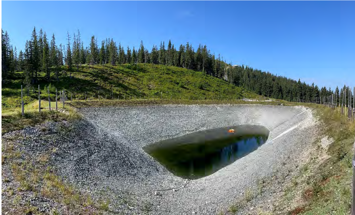
Abbildung 54: Blick vom Beschneigungsteich oberhalb der Karbachalm über den Nordteil des Standortraumes zur Bergstation der 6er Sesselbahn Fellersbach; Blickrichtung Südwesten (Quelle: REGIONALENTWICKLUNG, J. Leitner, 14.08.2021)
