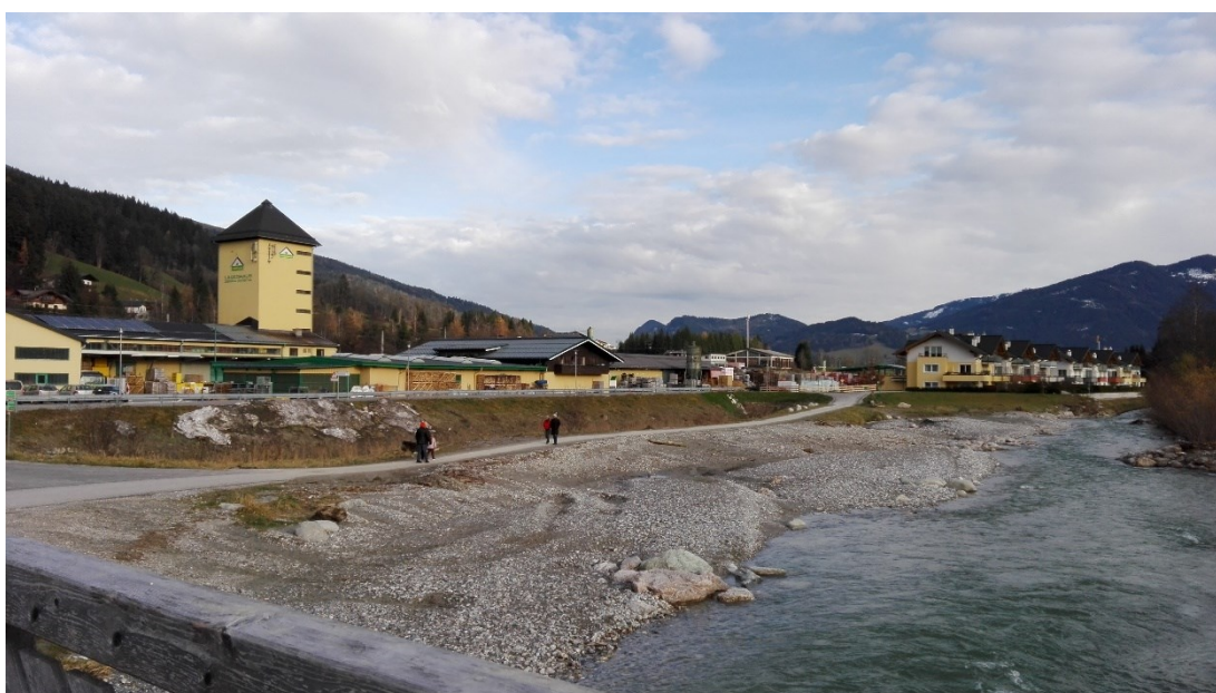
Abb. 5: Ansicht von Südwesten
