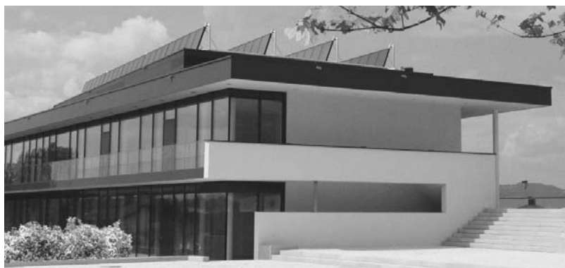
Das neue Veranstaltungszentrum in Hallwang wird nur mit der Sonne beheizt. Betonkernaktivierung ermöglicht die Nutzung und Speicherung von thermischer Sonnenenergie.
