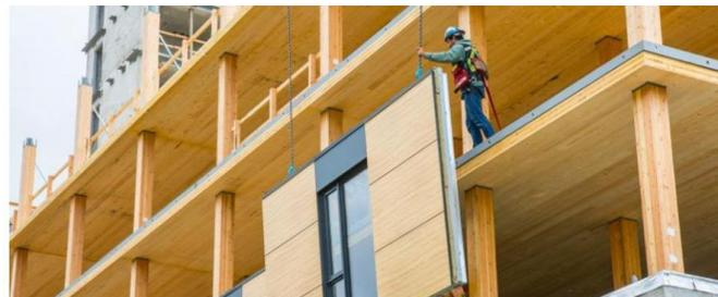
Abbildung 12 \_ Holzfertigteilbau,
