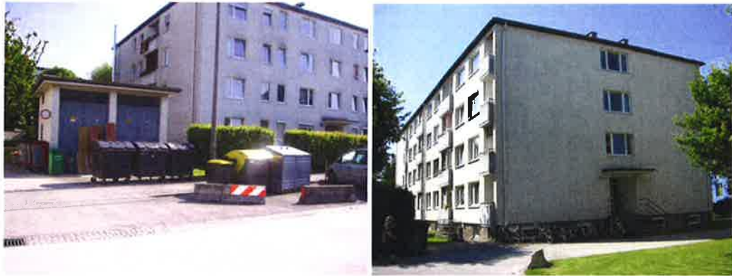
(Abb.: Freiraum vor der Sanierung; Foto: Salzburg Wohnbau)
