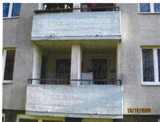
Bestandsbalkon für zwei Wohnungen
