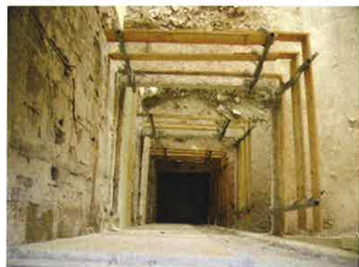
Ausschachtung für Aufzug
