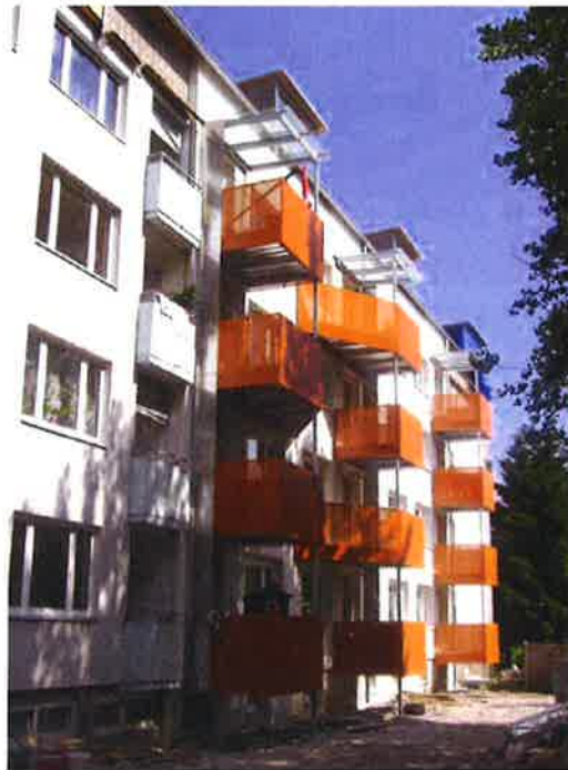
Ansicht der Balkone im Vergleich alt/neu: Balkone im Bestand (links) und die neu gestalteten Balkone (rechts)
