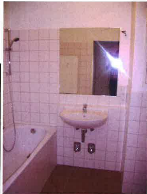
(Abb.: Beispiel Ausbau innen, Fotos: Salzburg Wohnbau)
