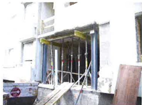
Umbauarbeiten für Eingang Neu
