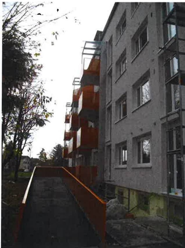
Barrierefreie Zugangsrampe
