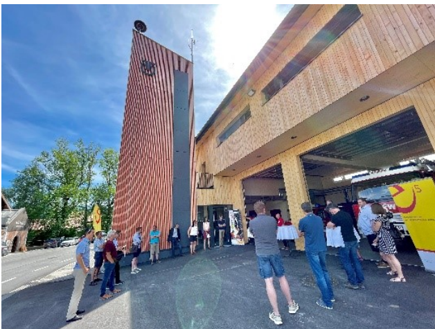
e5-Vor-Ort Thalgau-Unterdorf, Feuerwehr Holzmassivbauweise
