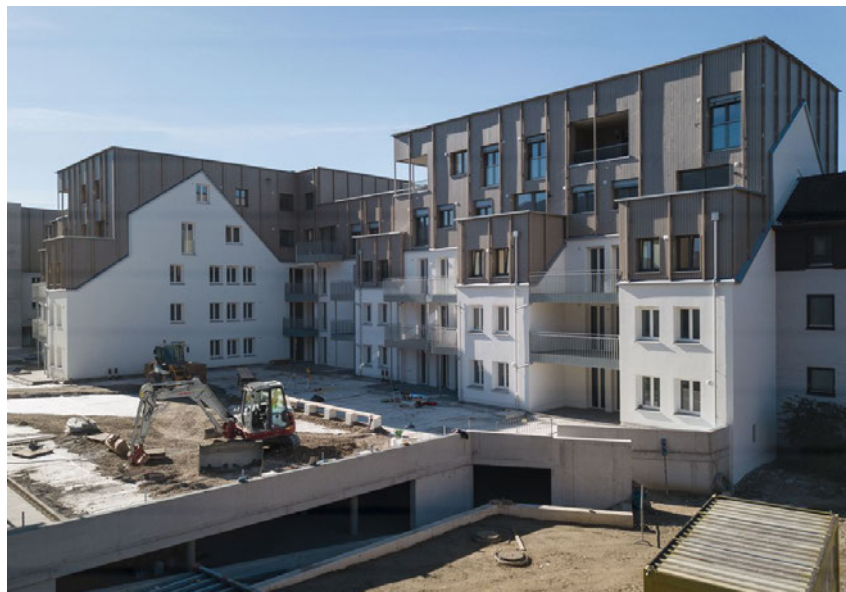
Innenhof kurz vor Fertigstellung im Oktober 2021, Foto: Christof Reich
