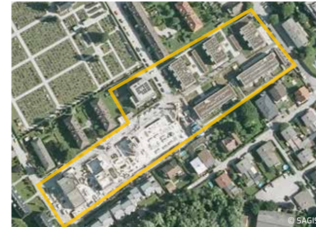
Nach Sanierung BA 1 und 2, Bauarbeiten BA 3
