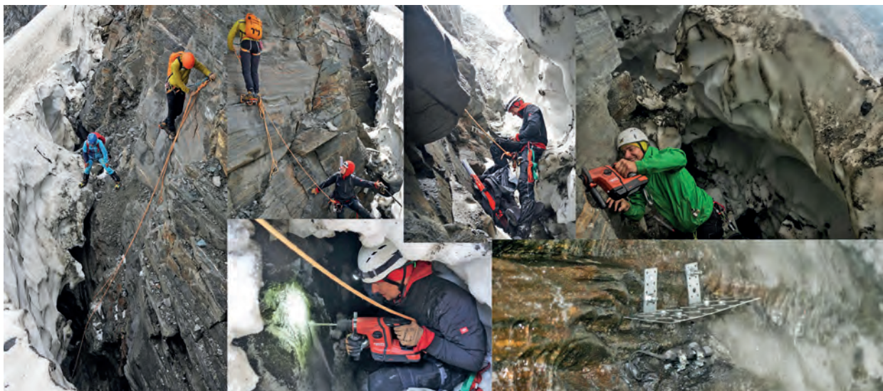
Figura 16: impressioni dei lavori di installazione nella crepaccia periferica il 25.07.2018 e il 22.08.2019 (foto: G. Valentin e R. Delleske).
