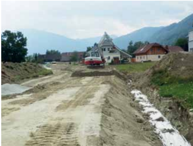
Von Mur abgesetzter HWS-Damm
