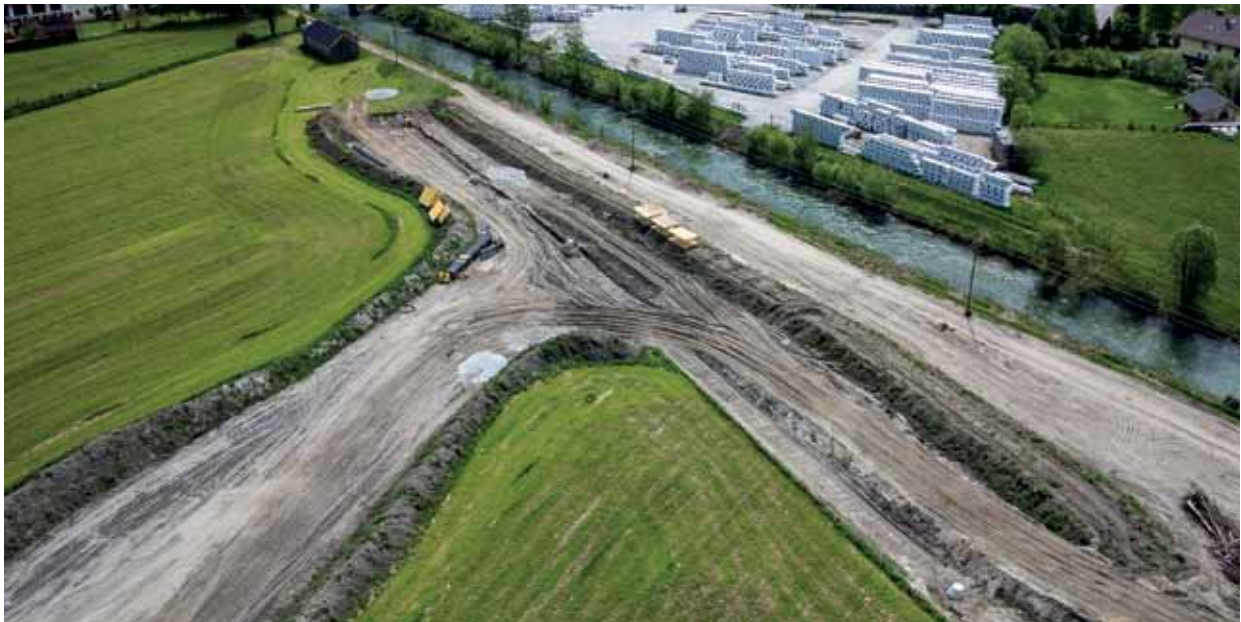
HWS-Damm und Muraufweitung während ....
