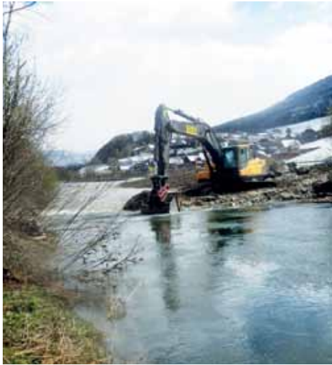
Arbeiten in der Niederwasserzeit
