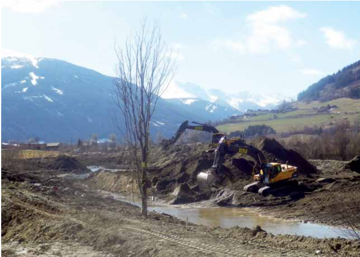
Erdarbeiten für Muraufweitung
