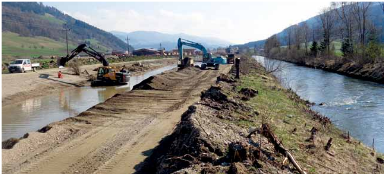
Aushubarbeiten für Muraufweitung
