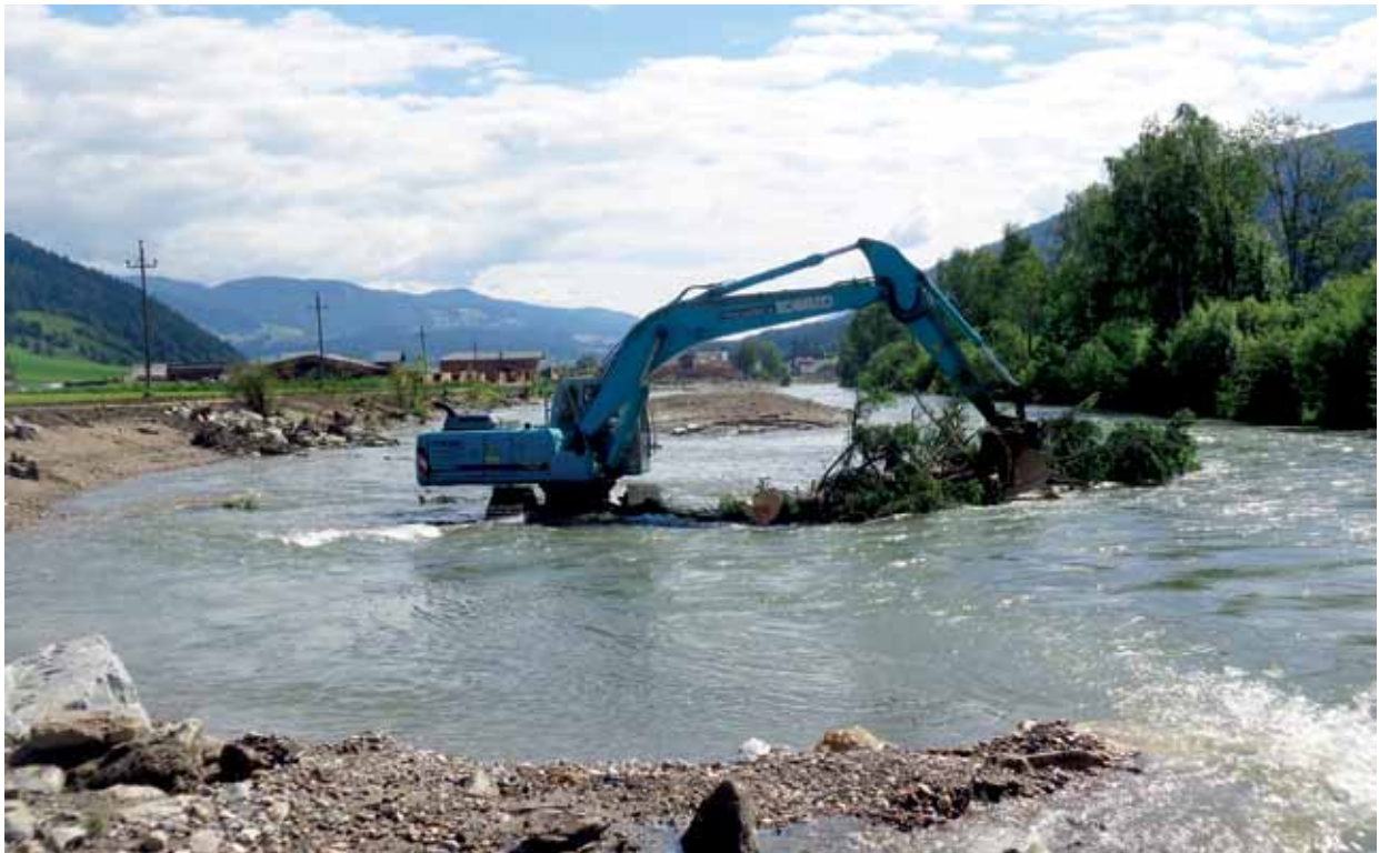
„Baustoffe“ für neue Uferstrukturierung
