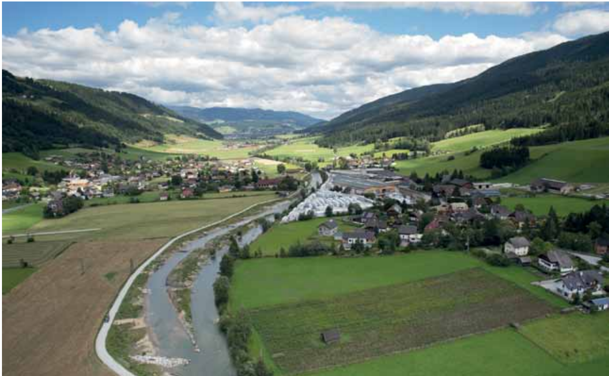
Schutzbauten kombiniert mit Flussaufweitung (Ortsbereich Unternberg)
