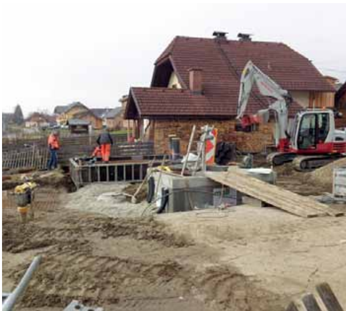
Errichtung des stationären Pumpwerks ....
