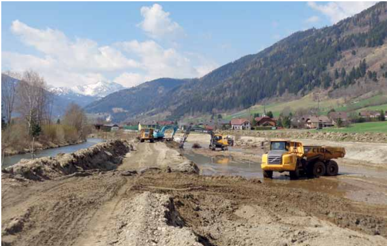
Baugeräteinsatz für Muraufweitung
