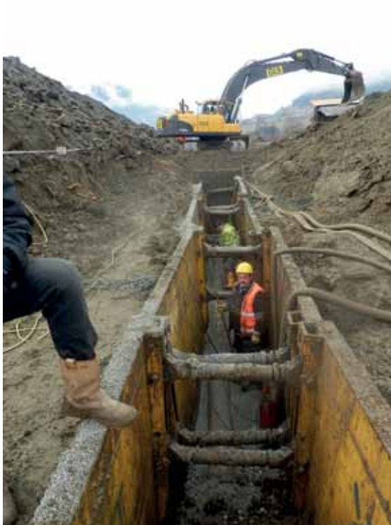
Künnettenverbau Kanalumlegung
