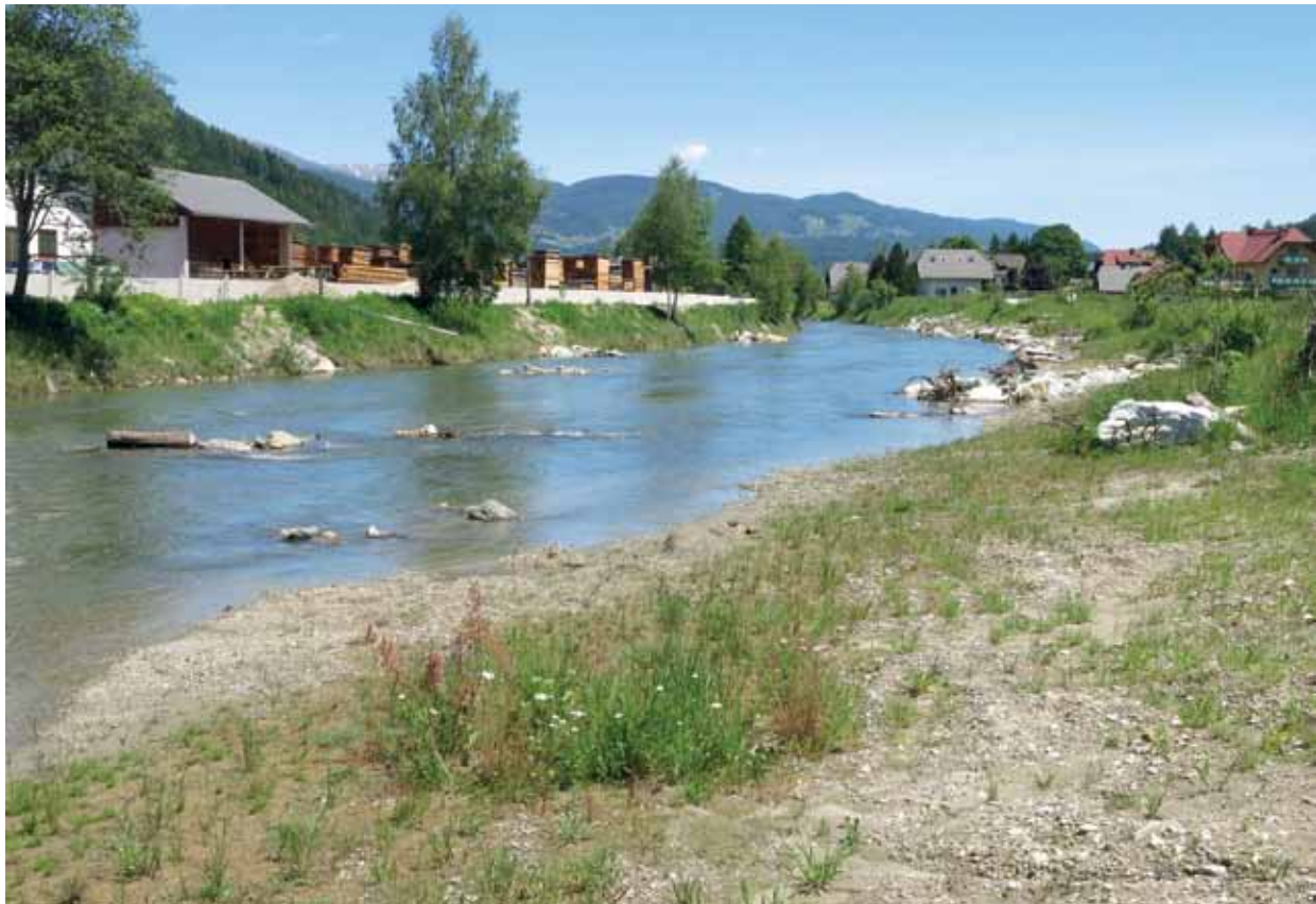
HWS-Mauer und Muraufweitung Sägewerk Graggaber
