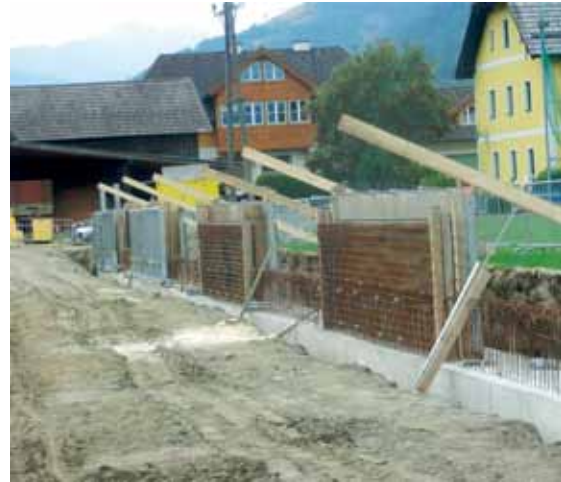
HWS-Mauer bei Sportplatz
