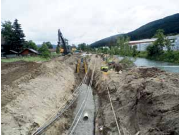
Leitungsumlegungen wegen Muraufweitungen
