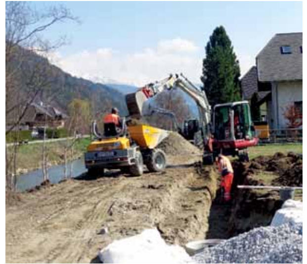
Aushub HWS-Mauer
