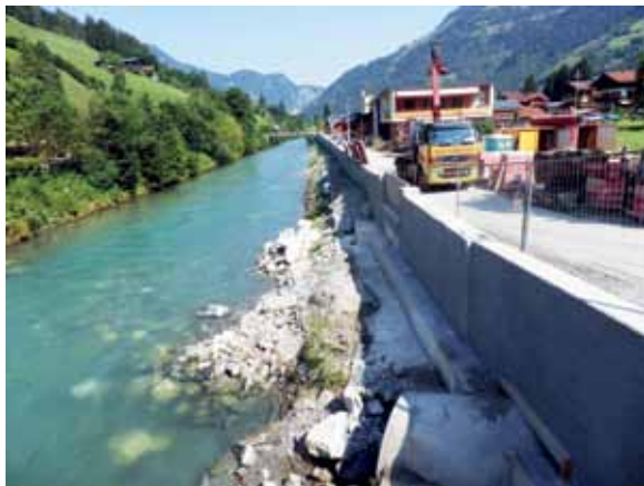
HW-Schutzmauer in Bau
