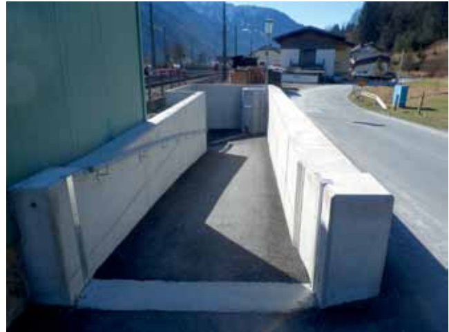
Schutzmaßnahmen für Gehwegsunterführung
