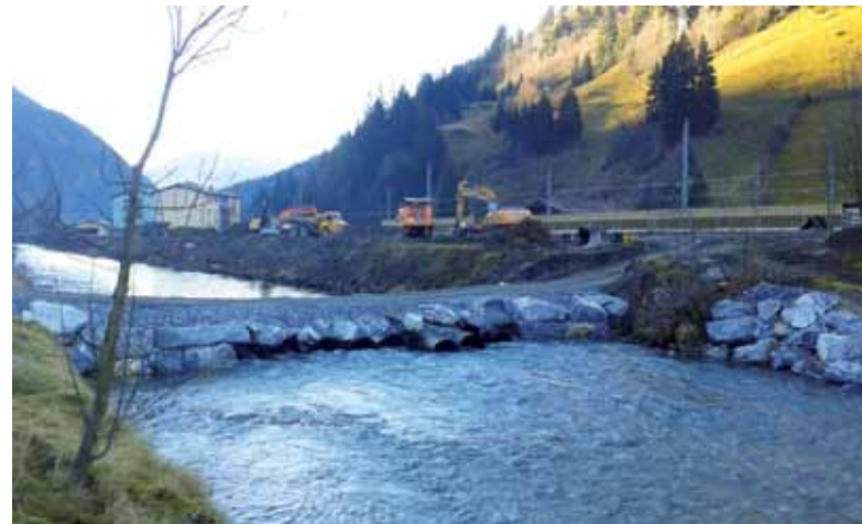
Baustraße über Gasteiner Ache, Aufweitung Bahnhofsbereich
