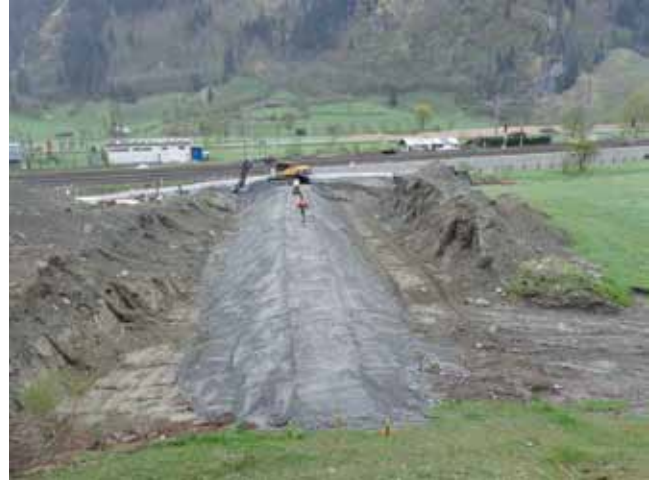
Schüttung des statischen Dammkerns Bereich Wiesenstraße
