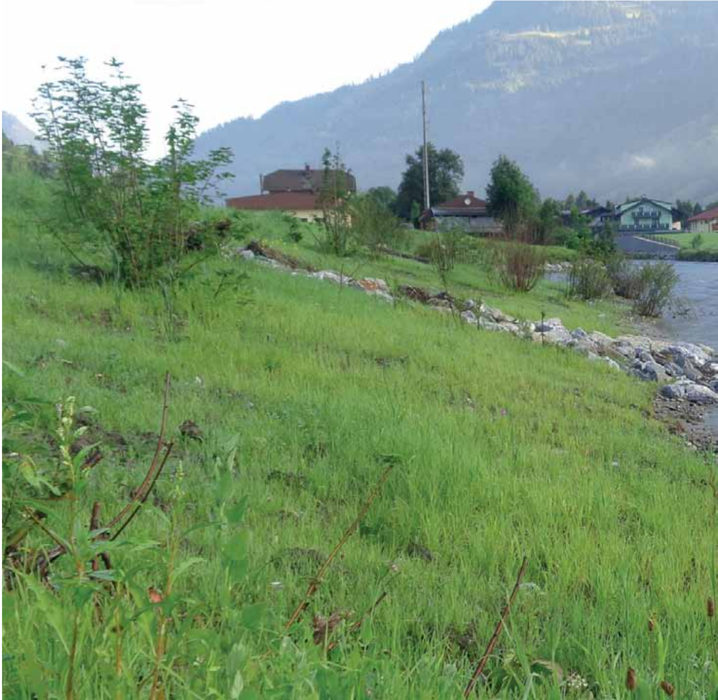
Aufweitung Gasteiner Ache Bahnhofsbereich - sowie Querdamm „Feld Rieser“, lineare Maßnahmen Ortsbereich und Salamandersiedlung
