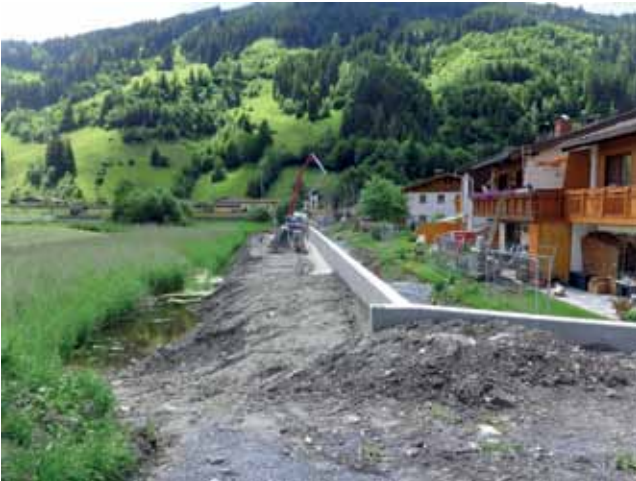
Errichtung Schutzmauer Salamandersiedlung
