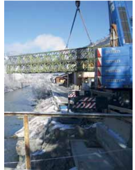
Behelfsbrücke in der Bauphase
