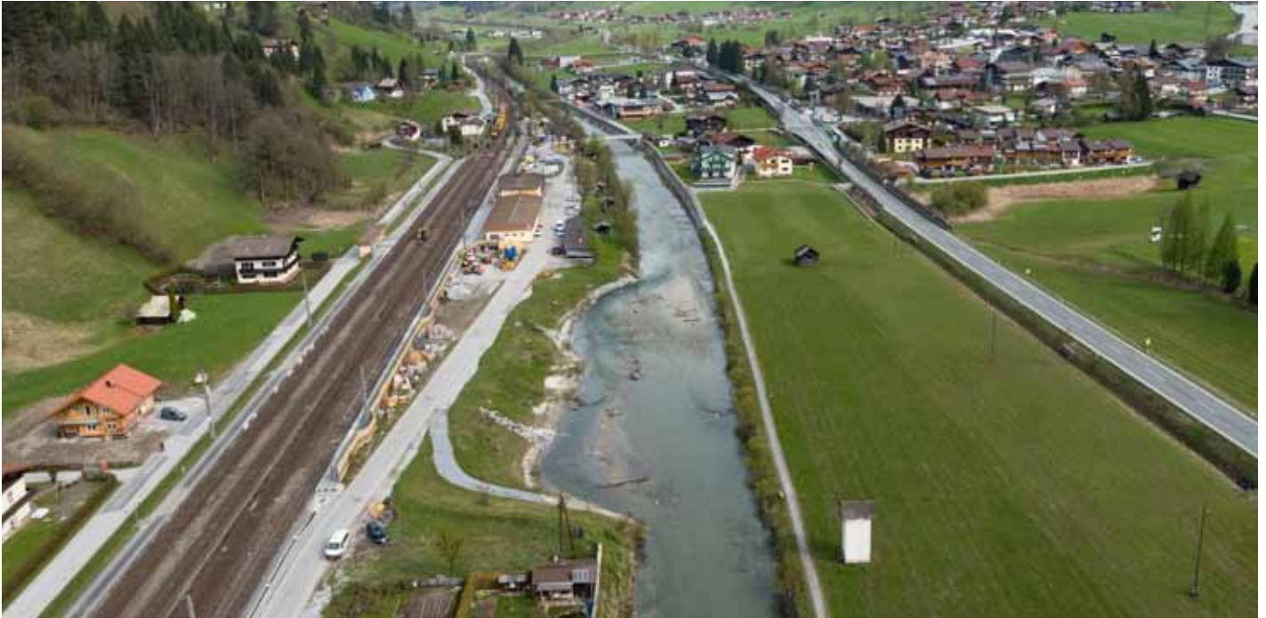
Ortsbereich von Dorfgastein mit ausgeführten Maßnahmen.
