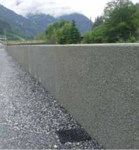
Bearbeitete Mauerwerksoberflächen
