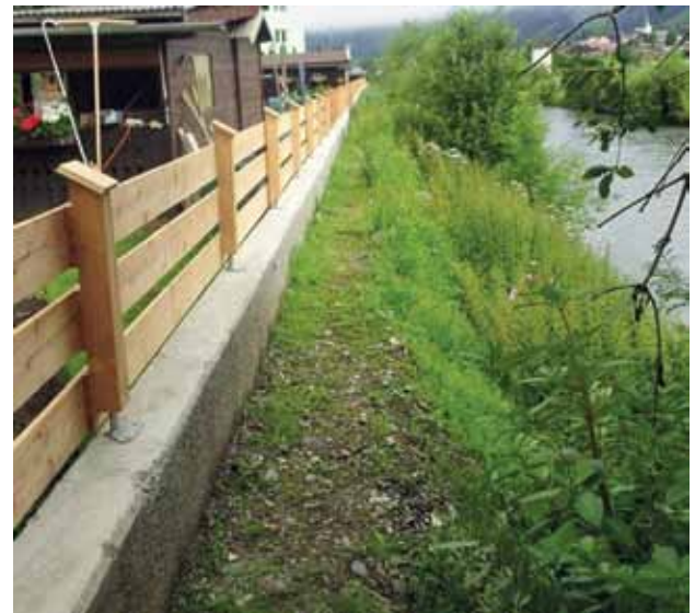
Neues Mauerwerk im Bereich der ÖBB Wohnblöcke
