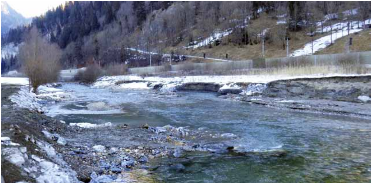
Aufweitungsbereich Unterberg direkt nach Fertigstellung der Arbeiten
