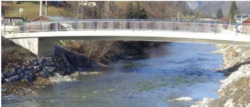
Neue Bahnbrücke mit hochwassersicherem Abflussprofil
