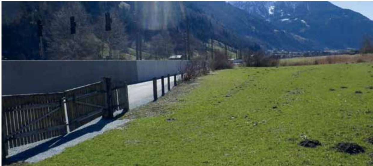
Mauerwerk neu Bereich Wiesenstraße
