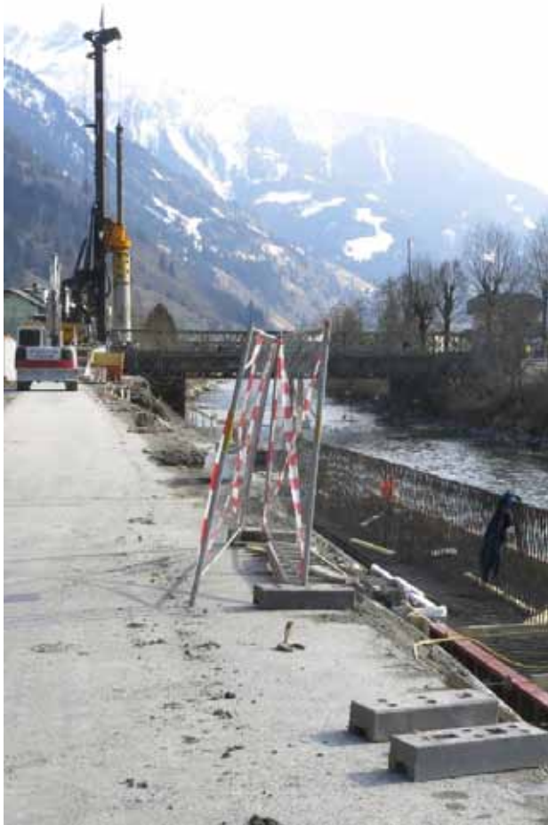
Fundierung HWS-Mauern und Bahnbrücke
