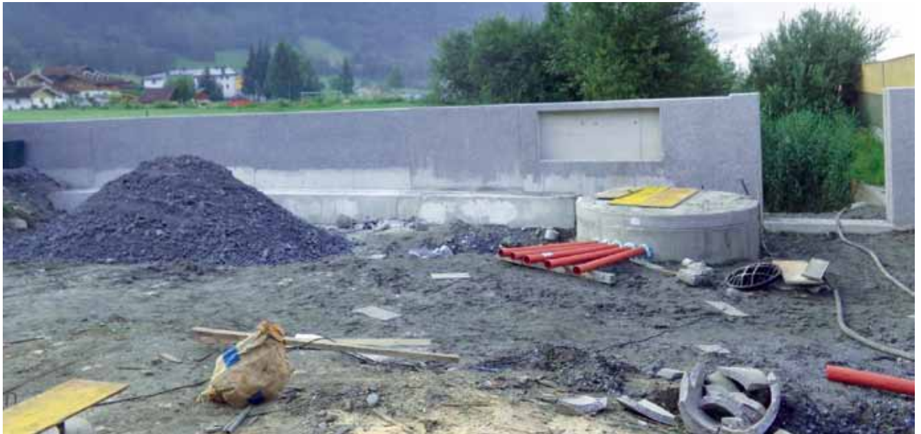
Errichtung des stationären Pumpwerks im Bereich Salamandersiedlung
