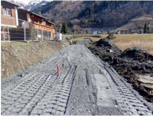
Statischer Dammkern mit eingebautem Setzungspegel...
