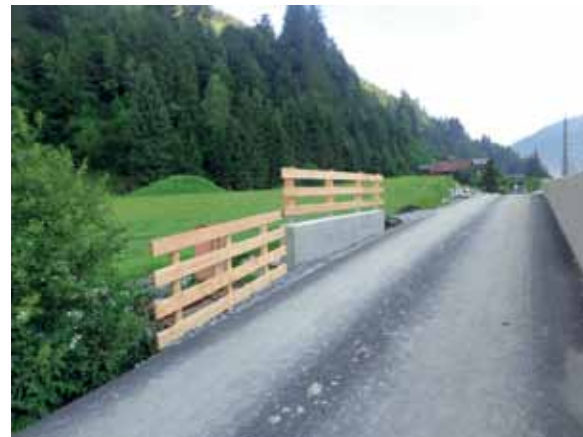
Neuer Übergang HW-Schutzdamm Wiesenstraße
