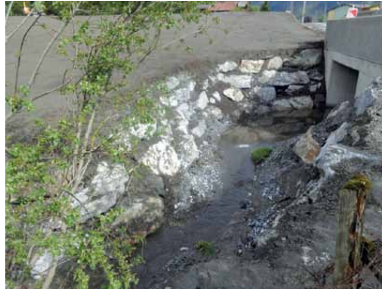
Durchführungsbauwerk & Einlauf Wiesengraben neu
