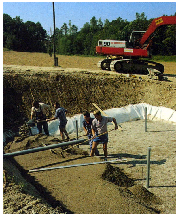
Bau einer „Pflanzenkläranlage“
